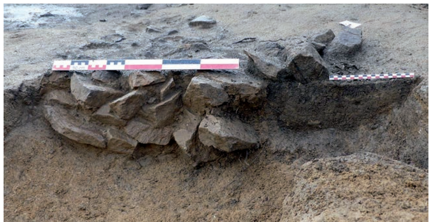
Fig. 357 Coupe transversale C.3 de la tranchée de fondation Us 1564 et de son radier Us 1565 observés au sein du sondage Sd.1564.3 (à droite, la fosse FS1874 qui les recoupe). © N. Ménez, Inrap
