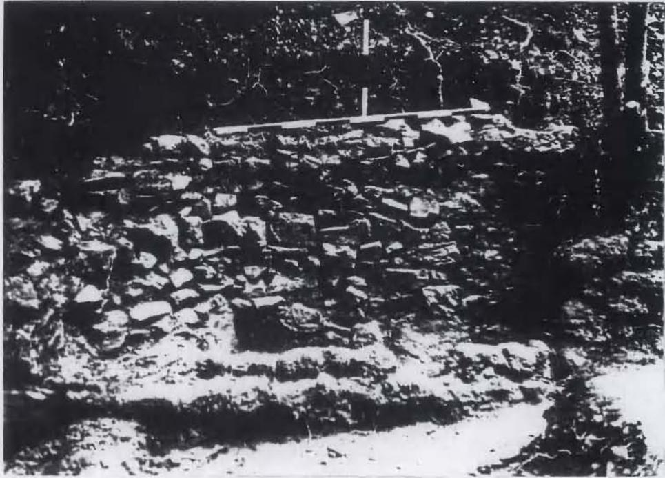
Edifice II. Cheminée murale maçonnée. On distingue au 1er plan, le parement de poudingues, en lit horizontal et en élévation sur la droite. Remarquer les fondations massives sur lesquelles est enté le contre coeur de la cheminée.
