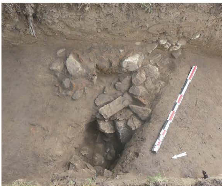
Fig. 14 : Le sondage effectué dans le radier 1011 n'a pas permis d'atteindre le fond de la tranchée de fondation du mur, particulièrement bien ancré. © Gaétan Le Cloirec
