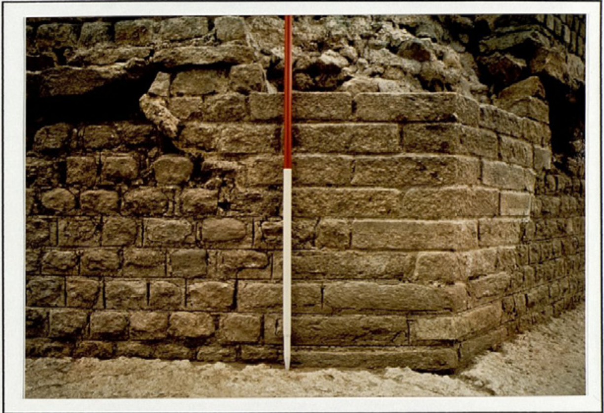
Temple du Haut-Bécherel, angle des pans extérieurs 1 et 2. Les joints au fer de la partie basse montrent que les trois premières assises sont d'origine. Les autres blocs d'angle ont probablement été remontés lors d'une restauration.
