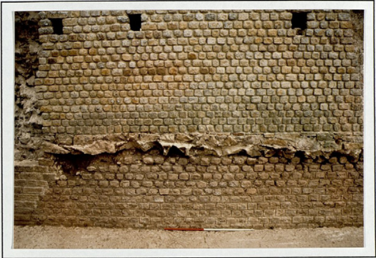
Temple du Haut-Bécherel, pan extérieur 1. Vue des gros blocs disposés au-dessus du parement d'origine et servant de fondation et de niveau plan aux nouvelles assises remontées lors des restaurations du siècle dernier.
