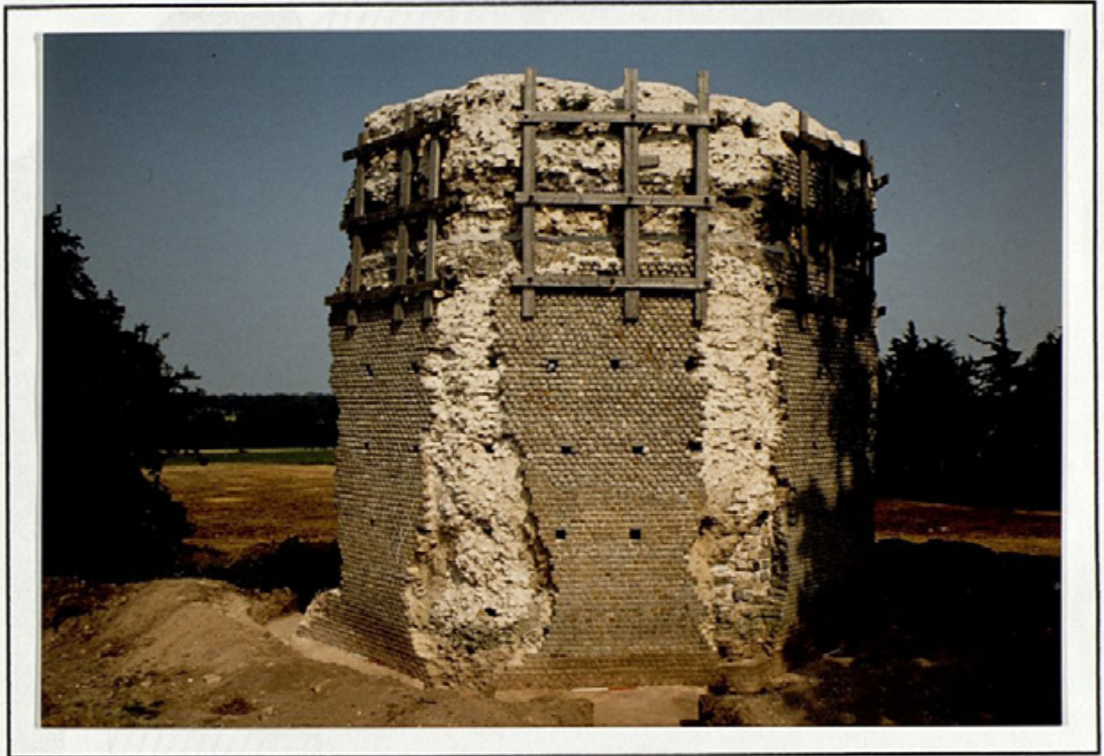
Vue du temple du Haut-Bécherel pendant les sondages avant les restaurations.
