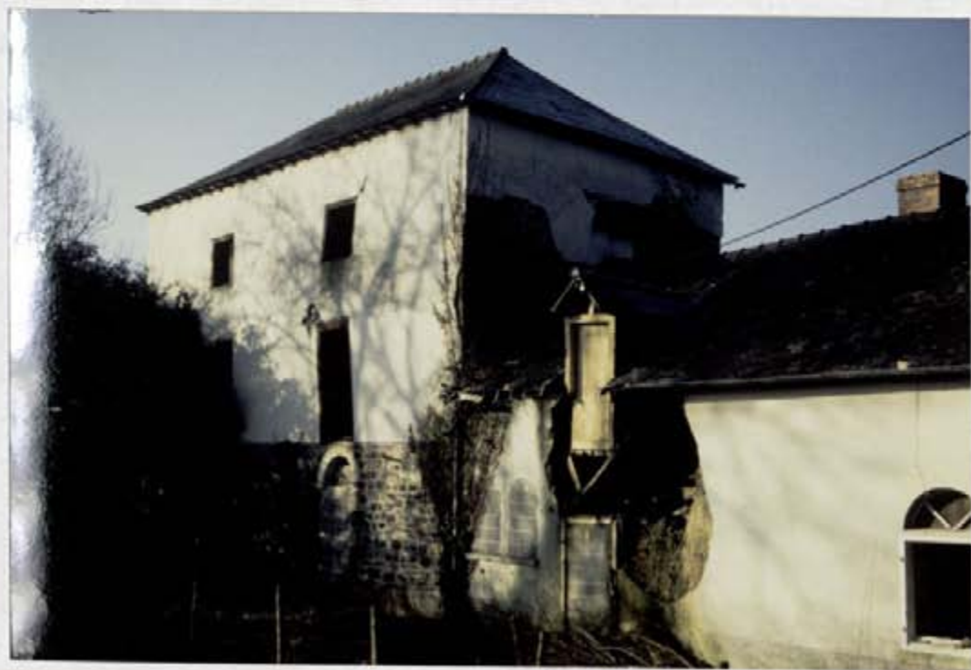
Cliché 8 bâtiment B et C vue d'ensemble.
