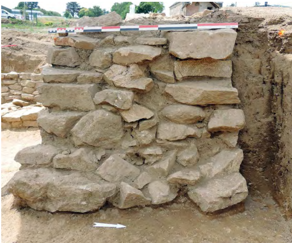
Figure 23 tranchée 1 : vue vers le sud de la coupe 8 : maçonnerie 122 © Inrap, Françoise Le Boulanger.
