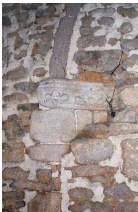
Figure 10 détail du piédroit gauche et de l'amorce de l'arc. Un chapiteau orné de fleurs de lys surmontées de trois bandeaux fait la jonction entre les deux © Bevan Gwelloc'h.
