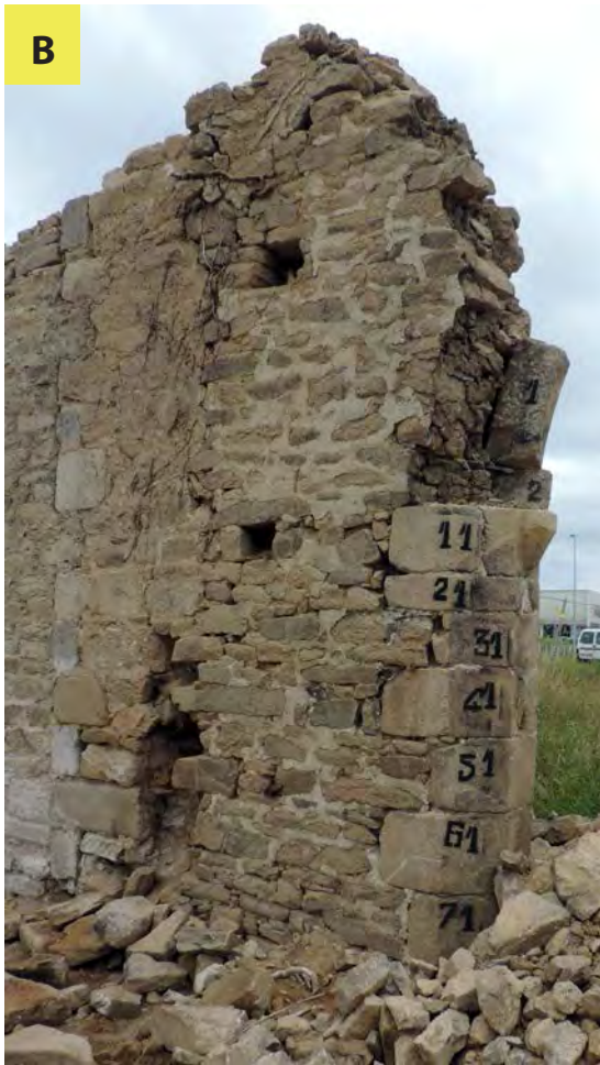
Figure 11 les vestiges de l'arcade encore en élévation le premier jour du diagnostic archéologique © Inrap, Françoise Le Boulanger A : vue vers l'est. Sont conservés le piédroit gauche et le début de l'arc ; les pierres du chapiteau ont déjà été arrachées ; les numéros sur les pierres ont été peints par les membres de l'association Bevan Gwelloc'h. B : vue oblique du piédroit nord de l'arcade. C : vue vers l'ouest.
