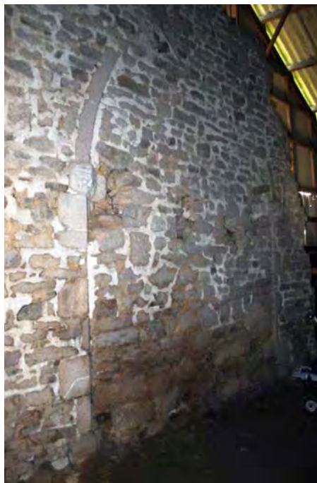
Figure 9 avant la démolition : vue en biais de l'arcade bouchée dans le hangar © Bevan Gwelloc'h.
