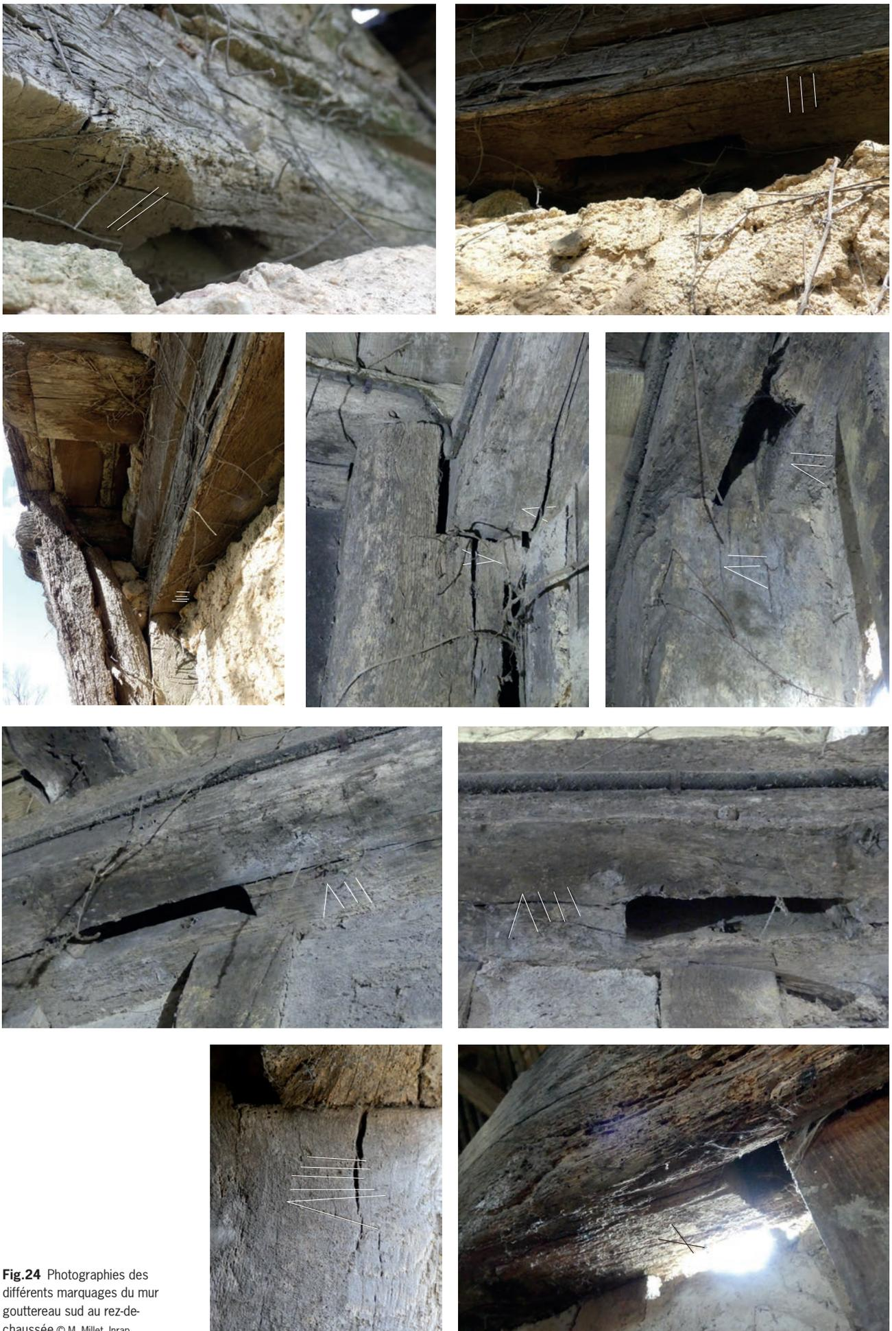
**Fig.24** Photographies des différents marquages du mur gouttereau sud au rez-de-chaussée © M. Millet, Inrap
