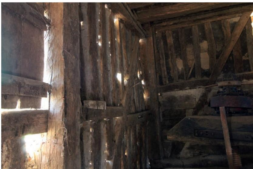
**Fig.39** Remplissage secondaire du rez-de-chaussée, us 114, vue depuis l'intérieur © H. Le Pichon, ALP
