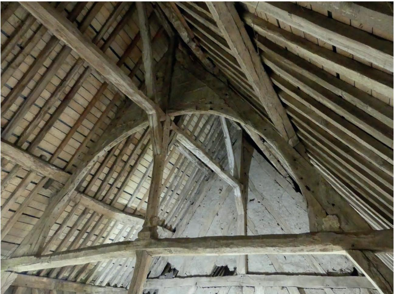
**Fig.58** Photographie de la ferme à poinçon long décoré, faux-entrait cintré sans aisseliers, us 144 © M. Millet, Inrap
