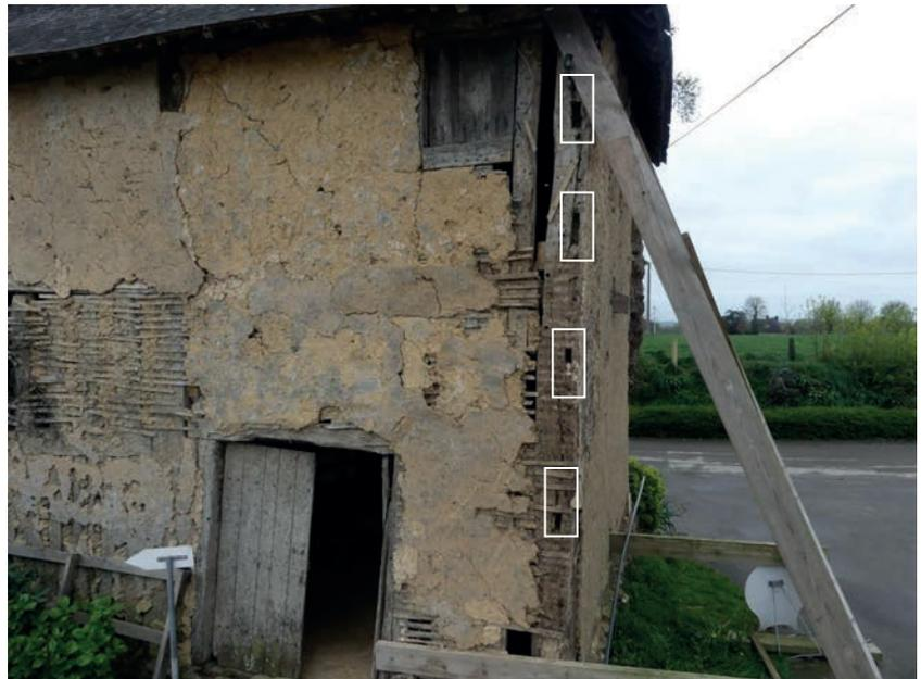
**Fig.45** Vue du poteau corner 105 et de ses mortaises vides sur toute la hauteur
