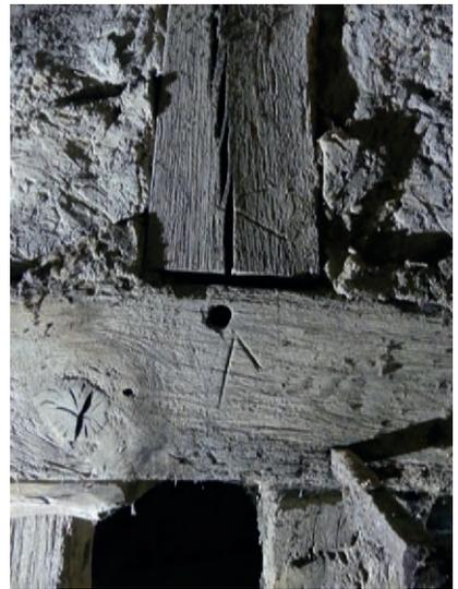
**Fig.54** Photographies des marquages découverts sur la charpente © M. Millet, Inrap
