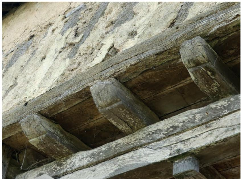
**Fig. 30** Les bouts des solives comportent une moulure © M. Millet, Inrap
