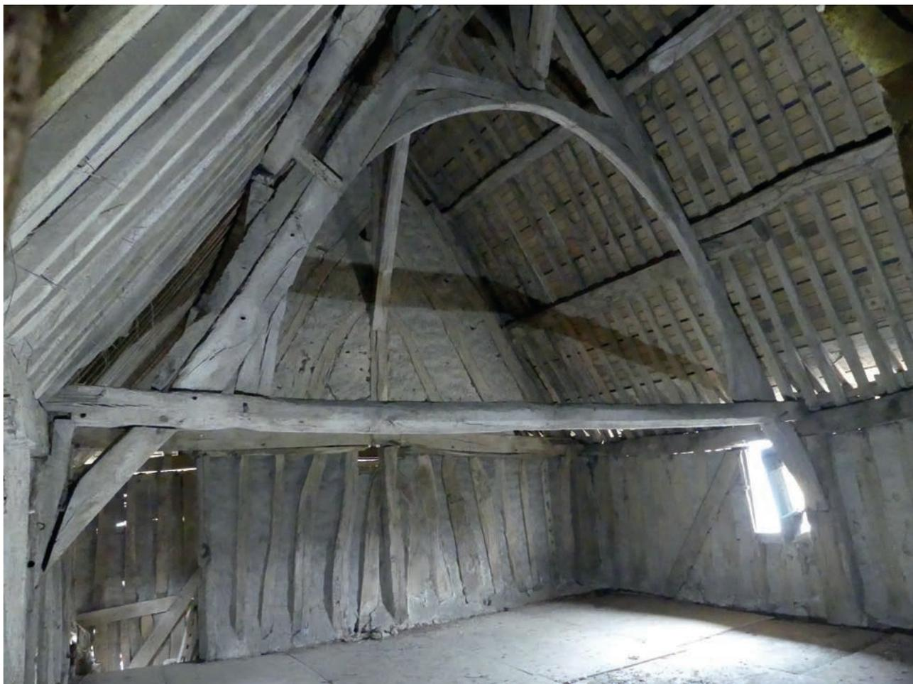
**Fig.56** Photographie de la ferme à poinçon court, faux-entrait droit et aisseliers, us 146 © M. Millet, Inrap
