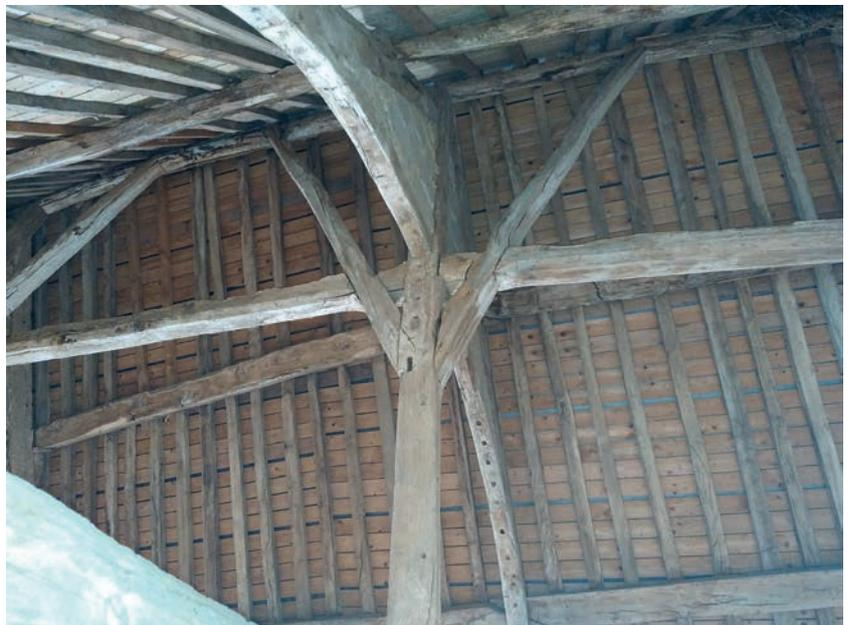
**Fig.59** Photographie du contreventement de la charpente dans la pièce sud du bâtiment © H. Le Pichon, ALP
