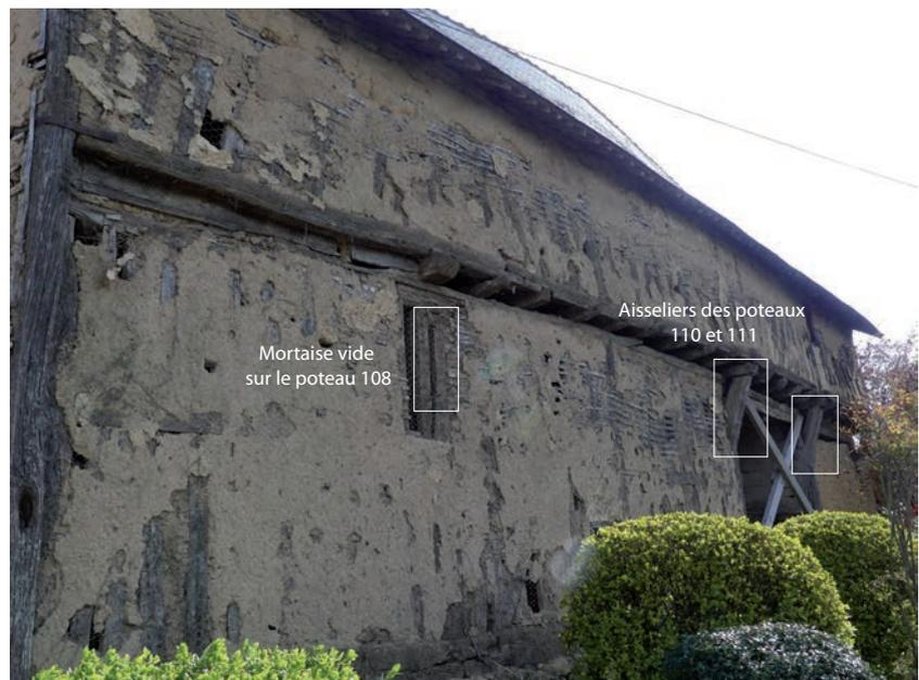
**Fig. 29** Mortaise vide du poteau 108 montrant l'existence ancienne d'un aisselier © M. Millet, Inrap
