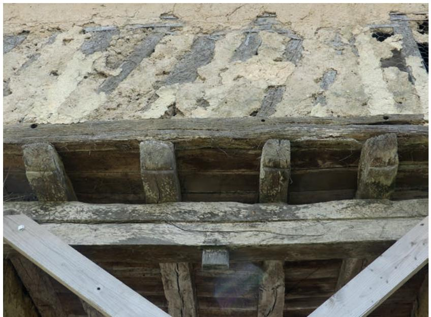
**Fig.22** Vue de la butée au centre du linteau du passage cochier © M. Millet, Inrap
