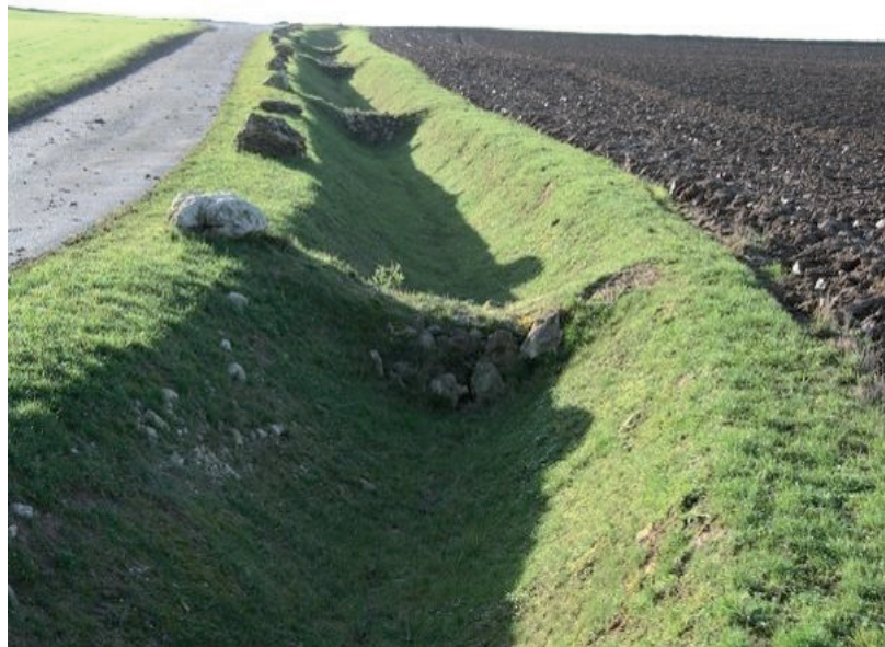
Fig. 23 Exemple de redents aménagés dans un fossé actuel © Inrap
