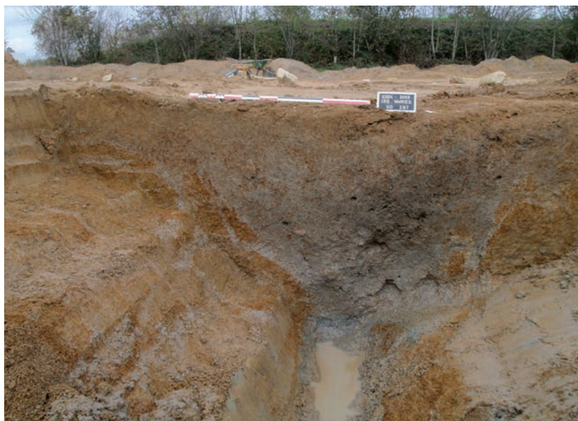
Fig. 179 Coupe nord du sd297 réalisée dans le fossé 206 sur laquelle on remarque les apports latéraux dissymétriques © Inrap
