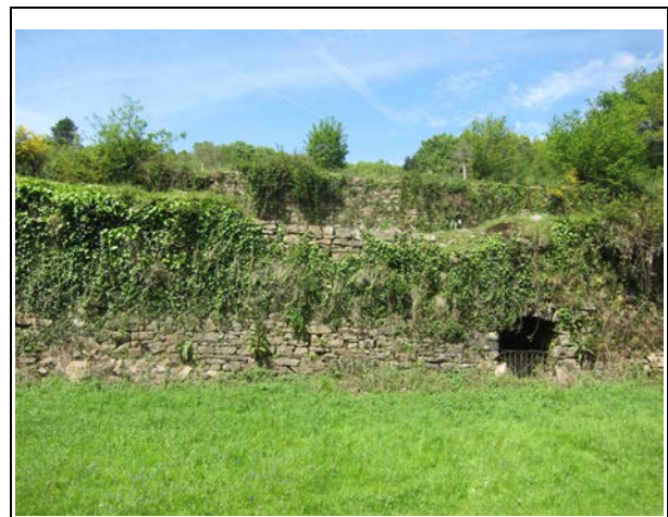
Photographie 3 : Maçonneries, soutenant T2, incluant une fontaine, vues depuis le sud
