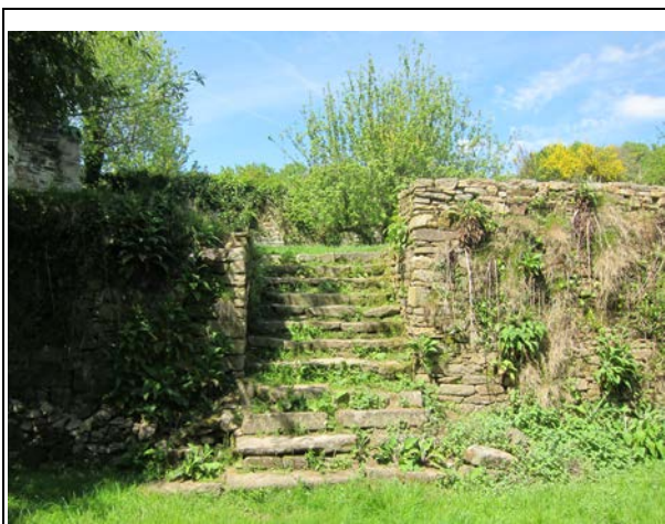
Photographie 2 : Escalier entre les terrasses T1 et T2 vu depuis le sud
