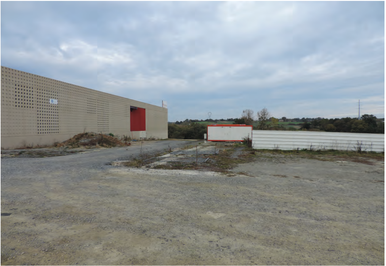
Fig. 11 : vue du transformateur à gauche © Jean-Claude Durand
