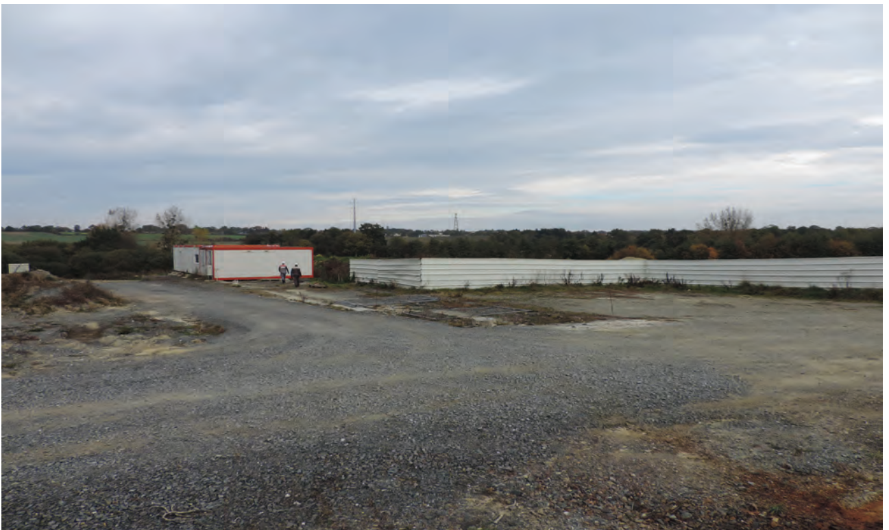
Fig. 12 : partie restante des installations de chantier et palissade sur l'emprise de la parcelle à diagnostiquer © Jean-Claude Durand
