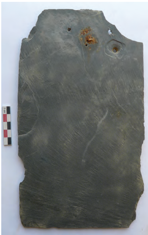
Fig. 129 : vue d'une des dalles de toiture en schiste © Françoise Labaune-Jean
