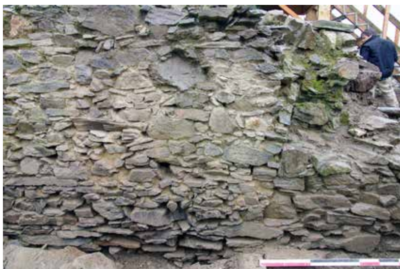
Fig. 27 : Détail de l'appareil du mur US 2528. A droite, le montant de l'archère US 2590, et la maçonnerie postérieure US 2709 qui l'a condamnée. Cl. R. Pérennec, CD29/Mission Archéologie.
