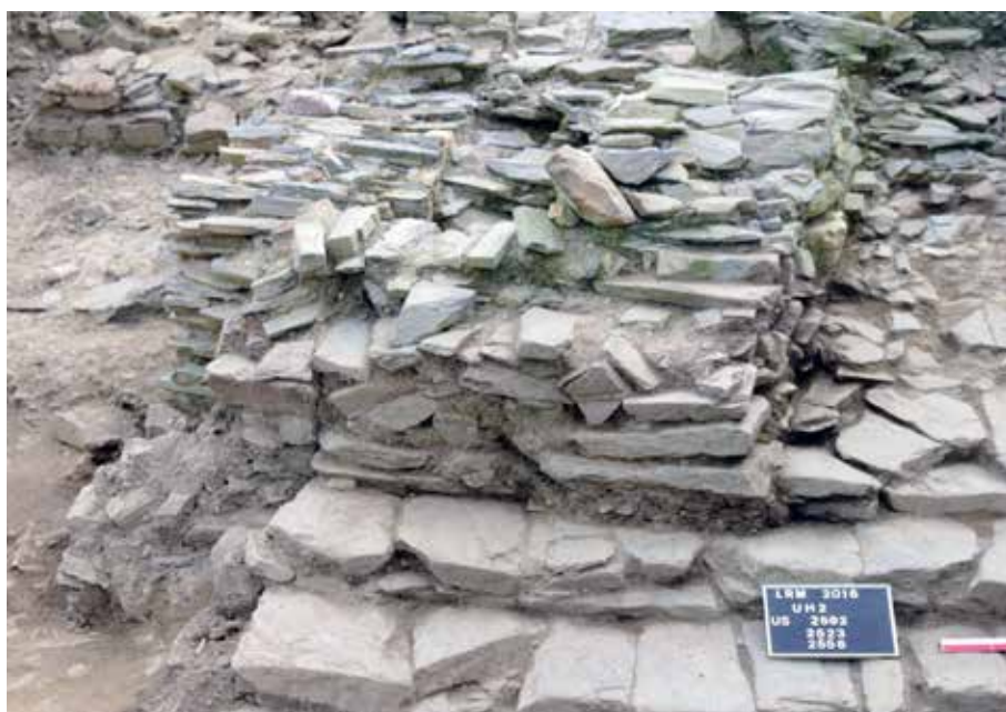
Fig. 42 : Angle des murs 2523 et 2556, construit sur l'escalier antérieur US 2592, et sur le bouchon maçonné US 2709, dans l'archère du mur médiéval arasé (à gauche). Cl. R. Pérennec, CD29/ Mission Archéologie.
