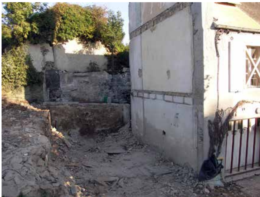
Fig. 95 : Emprise de la maison détruite. Vue du sud. Cl. R. Pérennec 2015, CD29/ Mission Archéologie.
