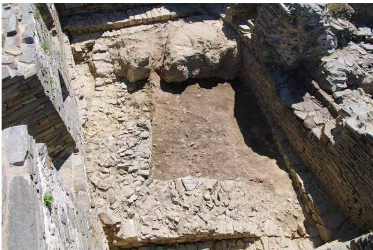
Fig. 7 : Vue générale de l'UH1. Au premier plan, le mur US 2112. A gauche, au pied de la courtine M31, le mur 2079/2133. A droite, sous le mur de façade M33, le mur US 2142, sur le parement US 2144. Vue prise du nord. Cl. R. Pérennec, CD29/ Mission archéologie.
