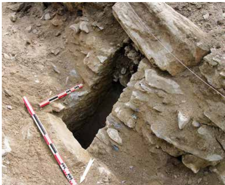
Fig. 93 : Conduit d'aération des fumées du moineau, US 3325, dans la tranchée de fondation ouest de la maison du patrimoine. Vue du nord. Cl. R. Pérennec, CD29/ Mission Archéologie.
