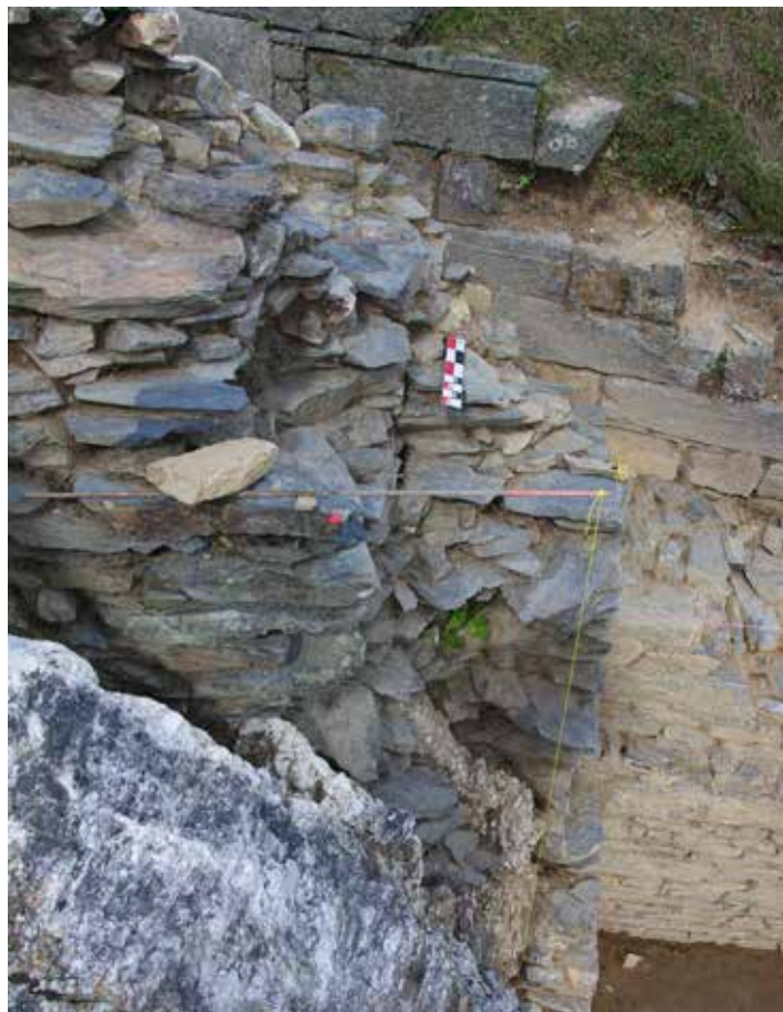
Fig. 49 : Au premier plan, l'angle du massif M43. On devine, à gauche de la mire, son parement sud US 2228, englobé par la maçonnerie de courtines postérieures, situées en contrebas. Cl. R. Pérennec 2014, CD29/ Mission Archéologie.
