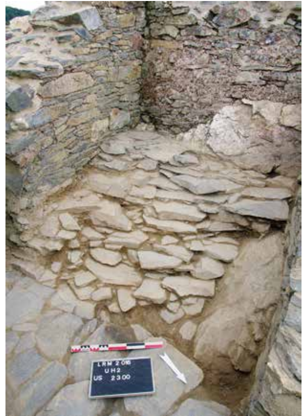
Fig. 48 : Semelle de fondation US 2300 supportant le massif maçonné M43. Au fond, la tour M35 ; et à gauche, le parement nord de la courtine M34, contre laquelle 2300 a pris appui. Vue du nord-est. Cl. L. Clouet, CD29/ Mission Archéologie.
