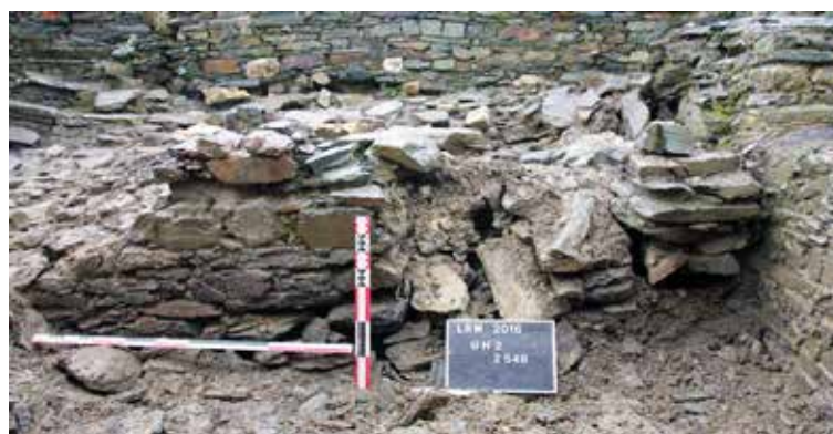
Fig. 31 : Vue du parement ouest de l'US 2548 après éboulement partiel. Vue de l'ouest. Cl. R. Pérennec, CD29/ Mission Archéologie.
