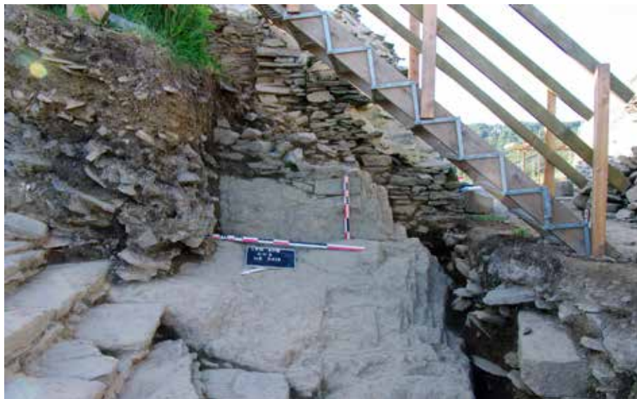
Fig. 38 et 39 : Le mur US 2412 sur son socle rocheux, au pied de la pile de pont M45. Au premier plan, l'escalier US 2592.
