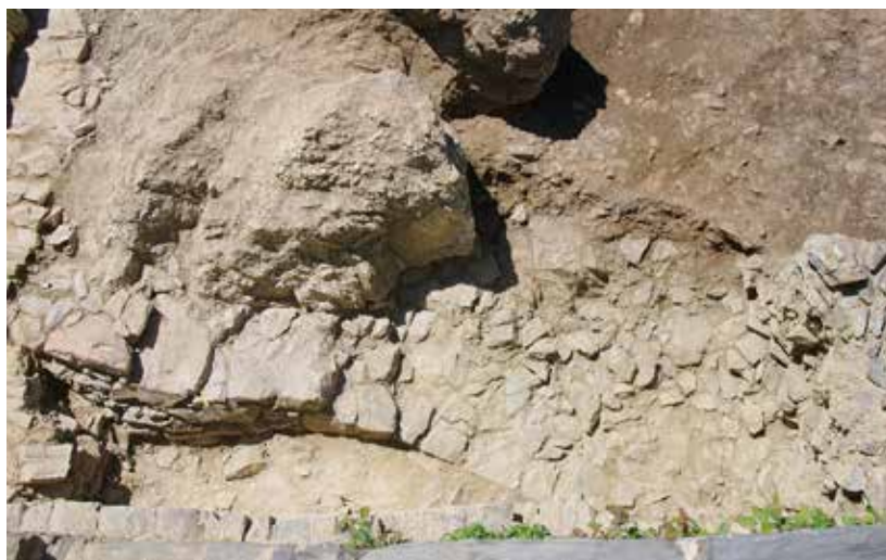
Fig. 10 : Parement courbe du mur 2133/2079, en glacis et enserrant la roche. Le parement interne était posé au sommet de celle-ci. Vue prise de l'est. Cl. R. Pérennec, CD29/Mission archéologie.
