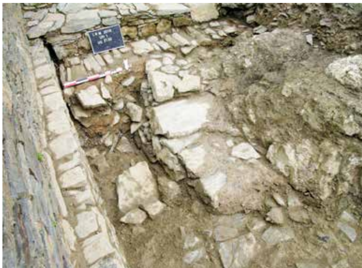
Fig. 19 : Vestiges de la semelle maçonnée US 2096, posée sur le mur courbe US 2133. A gauche, courtine M31 sur retrait d'aplomb US 2097/2107. A l'arrière-plan, les fondations de la tour d'artillerie. Vue du nord-est. Cl. L. Clouet, CD29/ Mission Archéologie.
