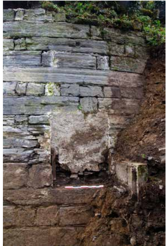
Fig. 98 : Emprise des latrines 3304 dans le parement de la tour. Les accroches de mortier gardent la trace des cloisons, et on aperçoit au-dessus le logement de la faîtière. Vue du nord-est. Cl. R. Pérennec, CD29/ Mission Archéologie.
