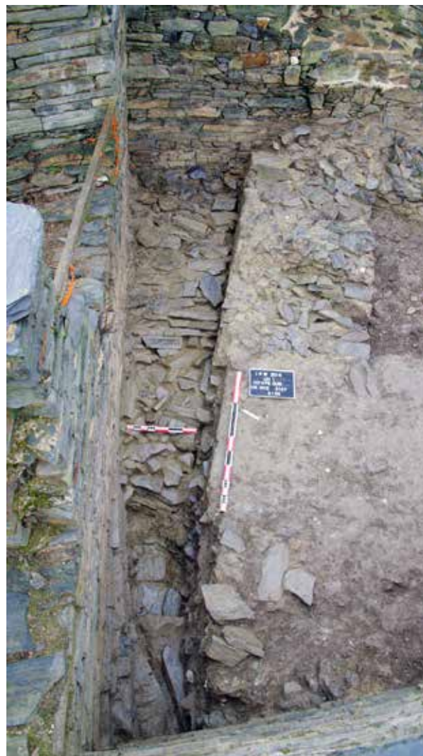
Fig. 16 : La semelle de fondation US 2134, sur laquelle est bâtie la courtine nord M32, sur son retrait d'aplomb US 2143, au premier plan à gauche. A droite, le mur US 2112 donne une idée de l'extension du château vers le nord, en phase 2. Vue de l'ouest. Cl. L. Clouet, CD29/ Mission Archéologie.
