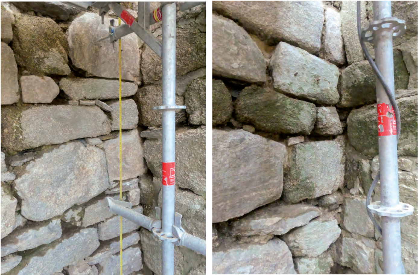
Fig. 13 Détails de pierres de parement de la courtine insérées dans la maçonnerie de la tour © R. Battais, Inrap
