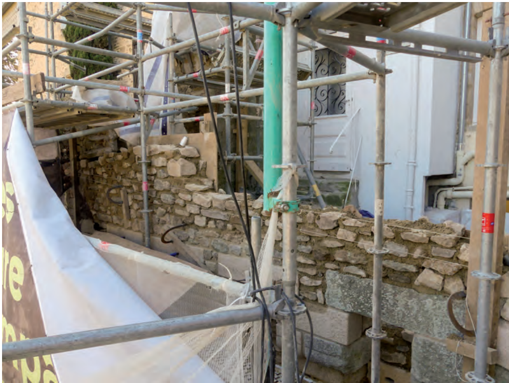
Fig. 4 Remontage du parapet en cours par l'entreprise de maçonnerie © R. Battais, Inrap
