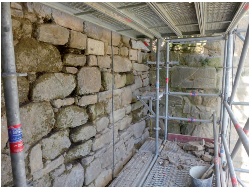
Fig. 7 Détail du parement composé de moellons de granit et d'orthogneiss © R. Battais, Inrap
