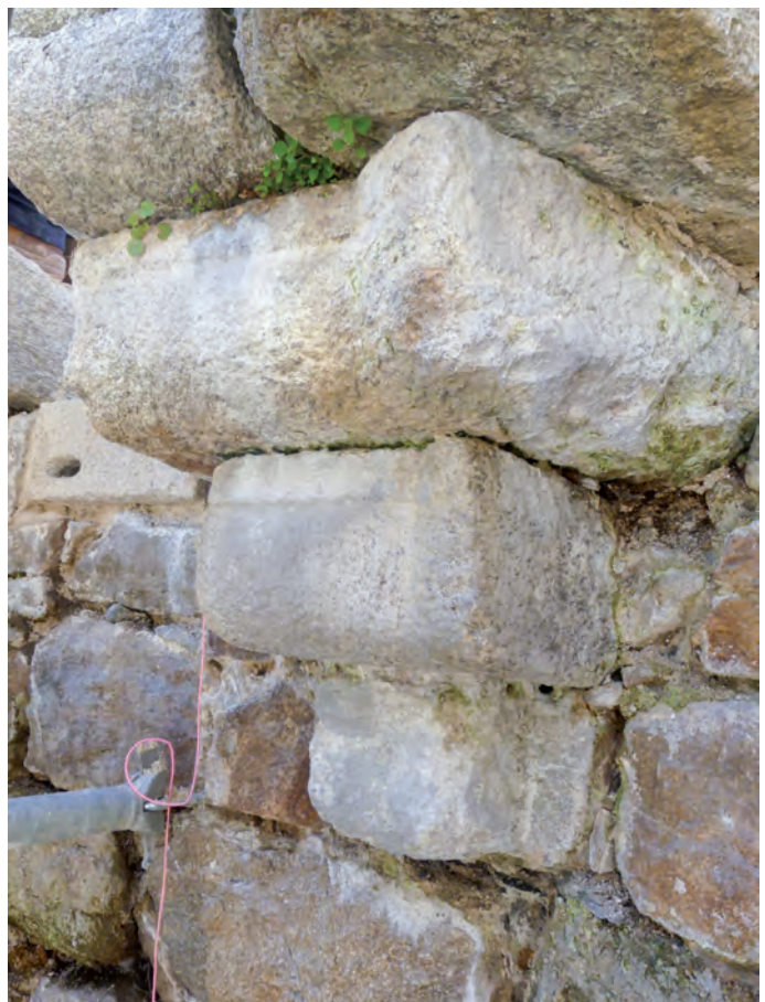
Fig. 12 Console de mâchicoulis taillée de manière à faire le chaînage lors du changement d'orientation de la courtine © R. Battais, Inrap
