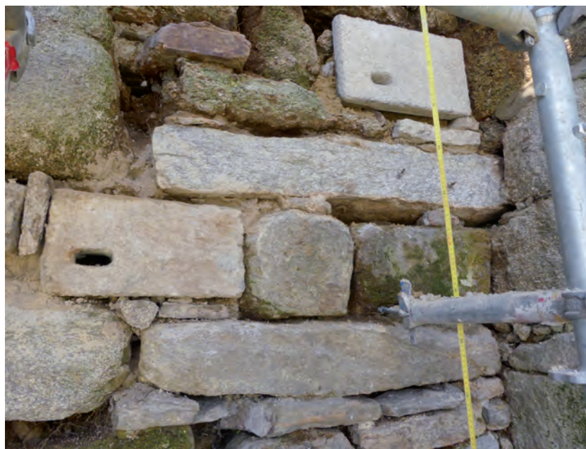
Fig. 5 Nichoirs pour les martinets installés dans le parement de la courtine © R. Battais, Inrap
