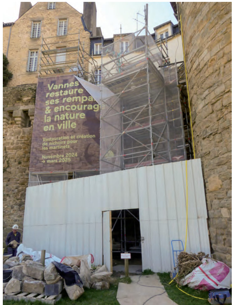
Fig. 3 Travaux de restauration de la courtine située au sud de la tour Poudrière © R. Battais, Inrap
