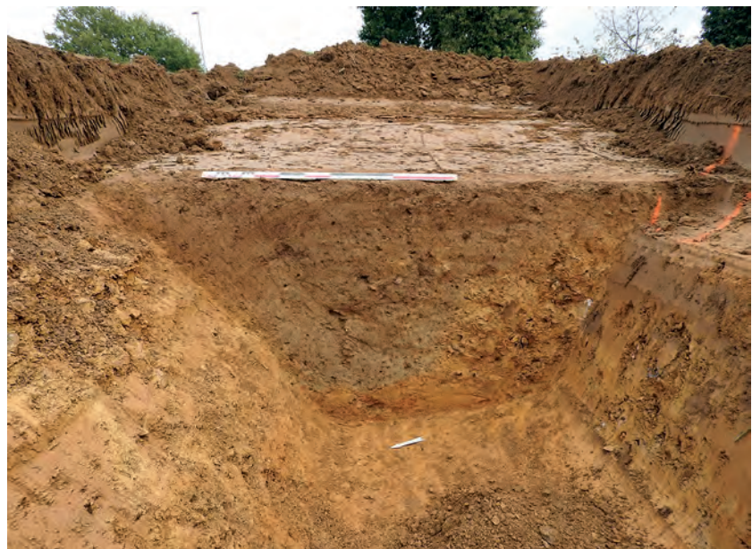
Fig. 11 Tranchée 2, coupe du fossé 28.
