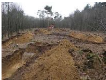
Photo 1: vue générale des tranchées dans la zone déboisée (cliché V.Guillon)
