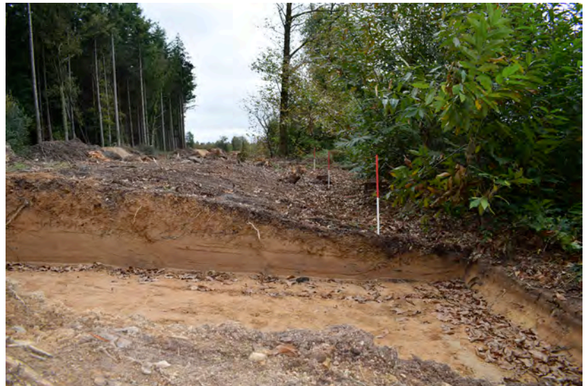
Cl. 52 Le même talus dans la tranchée 8. Cette fois, conformément à son environnement géopédologique local, il est constitué d'une masse limono-argileuse dont la largeur atteint 5 m. A cet endroit où la pente naturelle vers l'ouest est relativement importante, il permet le maintien horizontal de la chaussée © G. Leroux, Inrap
