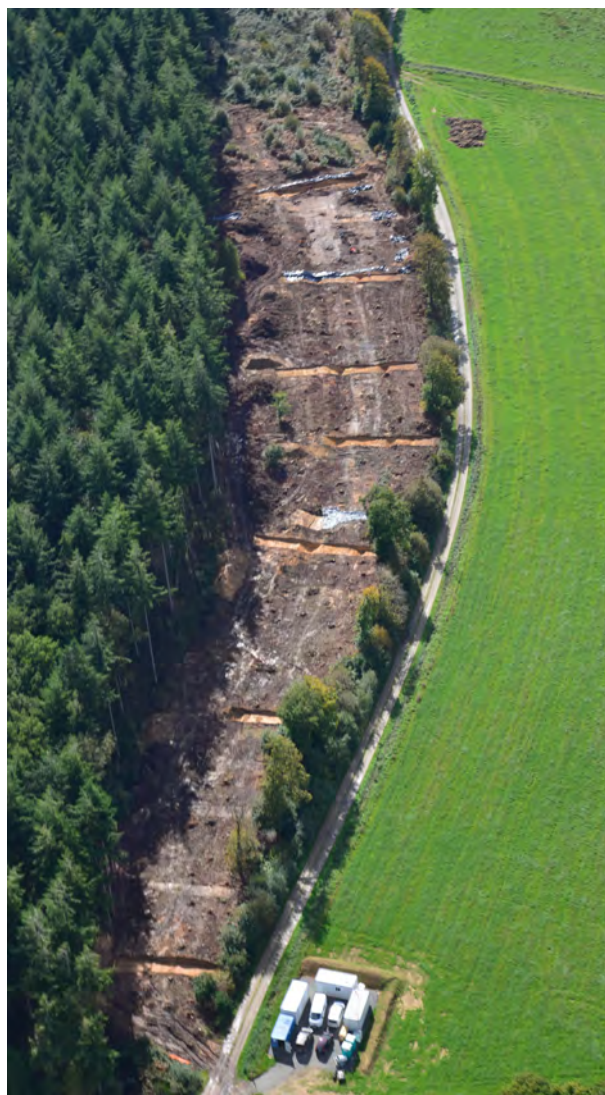
Cl. 22 Vue aérienne du chantier, depuis le nord © M. Gautier
