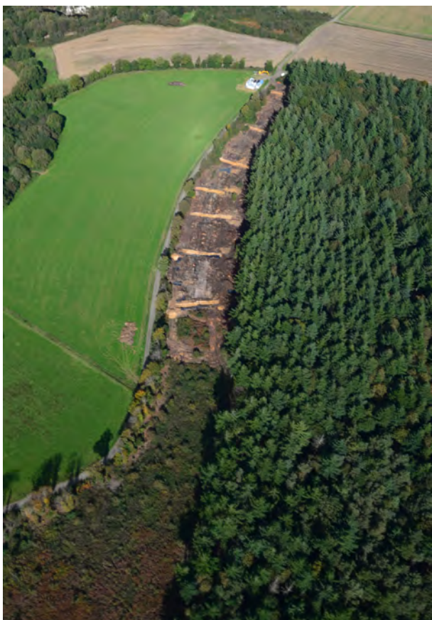
Cl. 21 Vue aérienne générale du chantier, depuis le sud © M. Gautier
