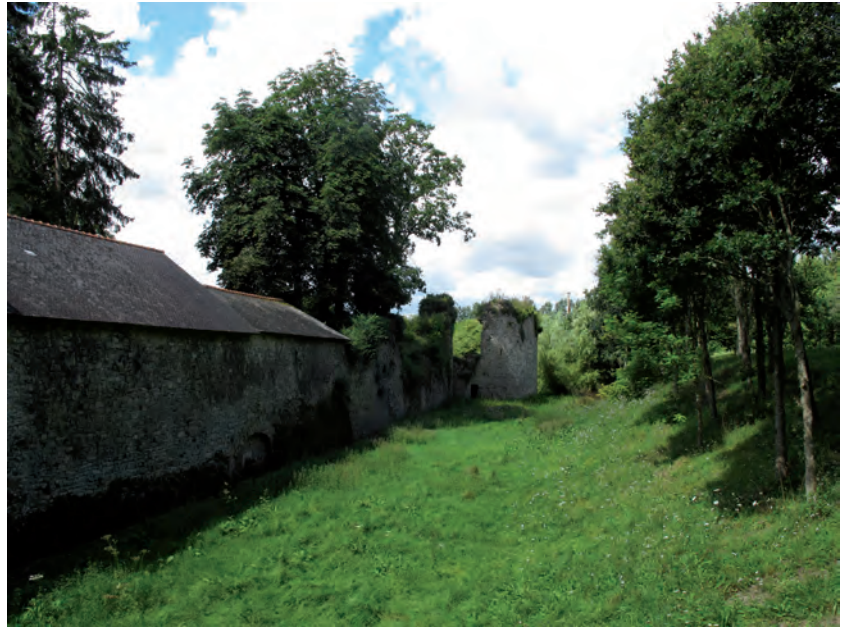
Fig. 11 Les douves et la tour nord-ouest du château du Bordage. Crédit Emmanuelle Ah Thon, Inrap
