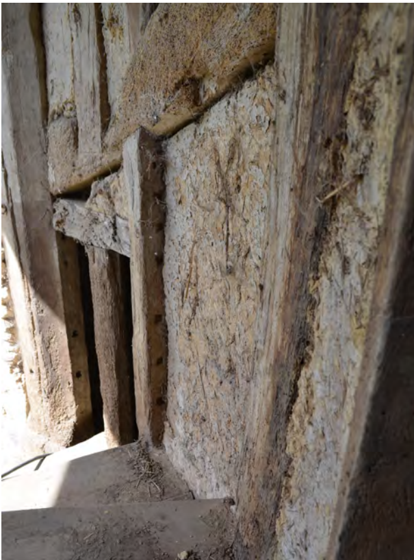
Fig.43 Les encoches de clayonnage © M. Millet, Inrap
