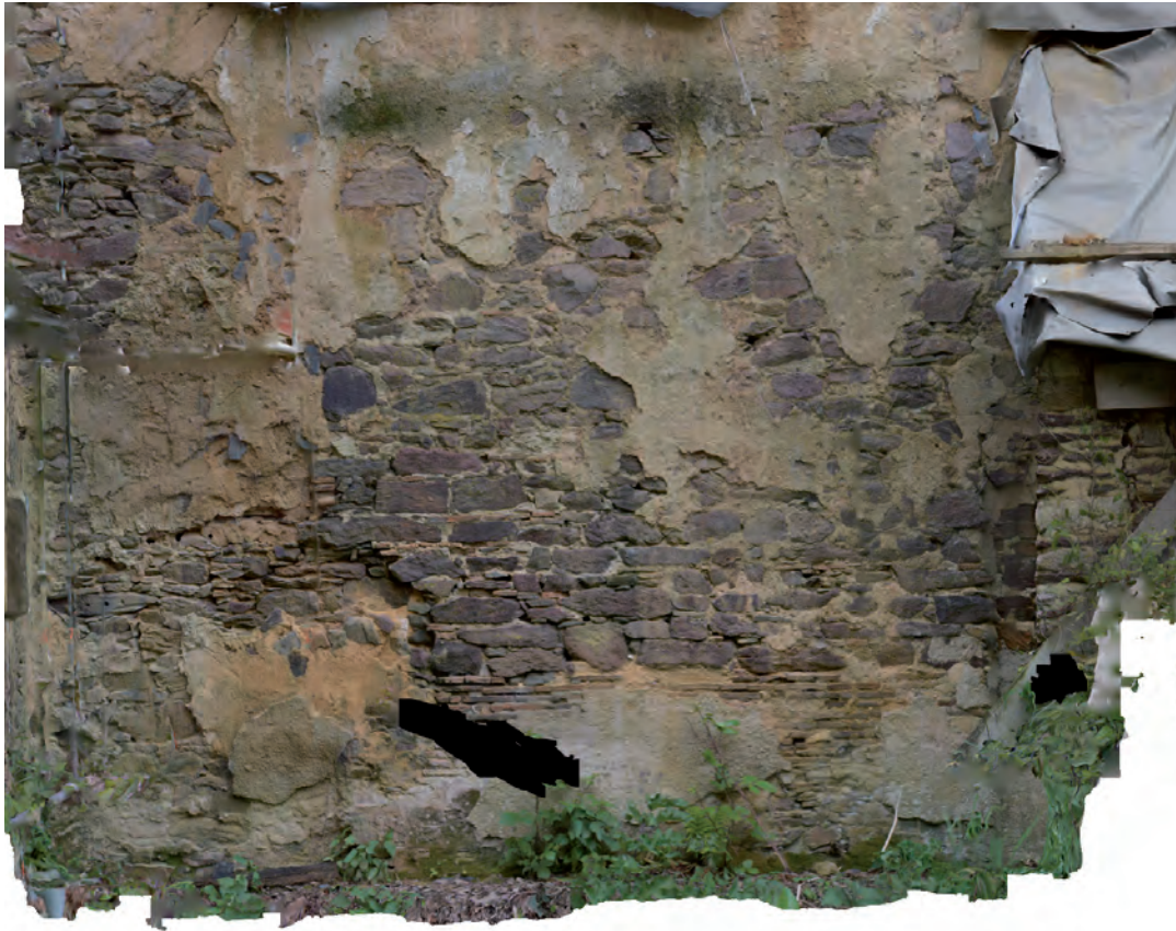
Fig.13 Le conduit primitif © Photogrammétrie P. Leblanc. On observe l'emploi de briques dans la mise-en-œuvre.
