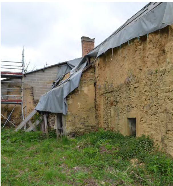
Fig.135 La cage d'escalier demi hors-cœuvre maçonnerie © E. Esnault, Inrap
