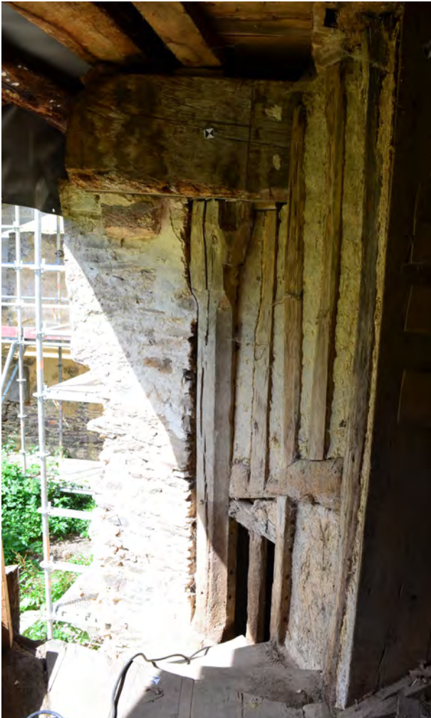
Fig.42 Le poteau d'escalier © M. Millet, Inrap
