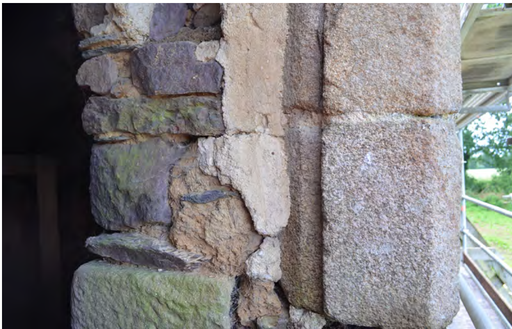
Fig.130 Le réemploi d'une ancienne fenêtre dont les ébrasements sont bûchés © E. Esnault, Inrap
