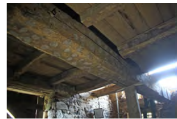
Corps principal, partie ouest, plancher du 1er étage
