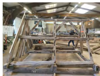
Chapitreau, charpente de couverture versant ouest
