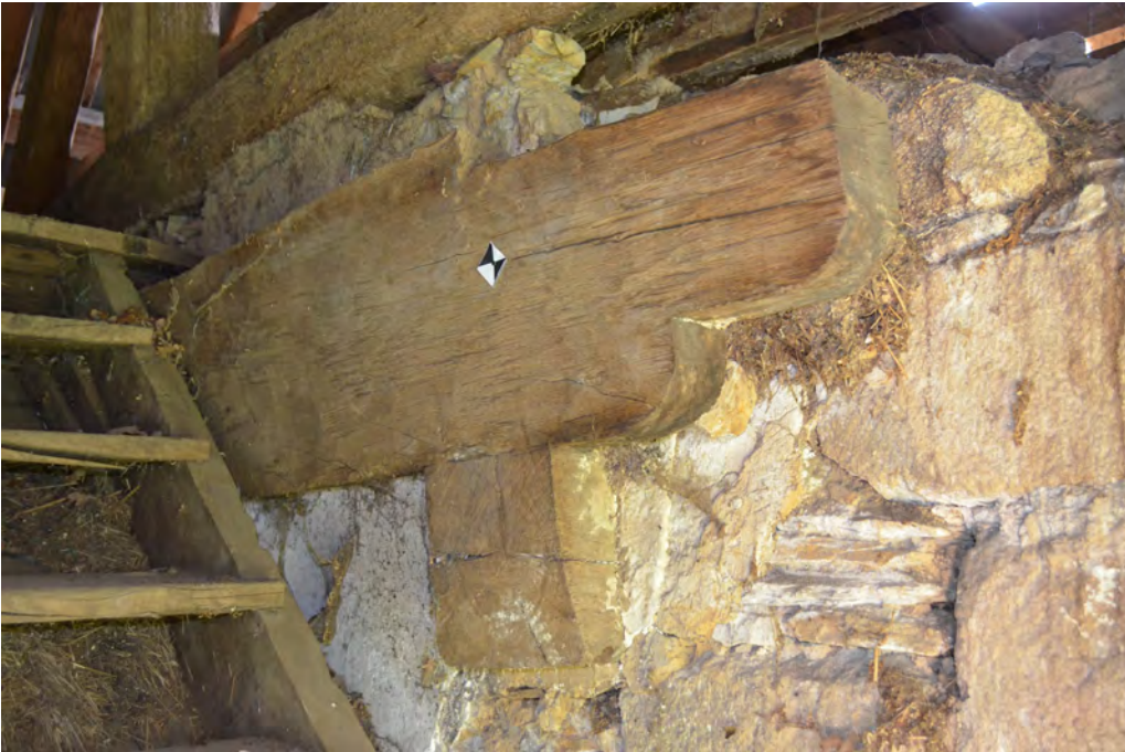
Fig.57 Le corbeau soutient du plancher inséré © M. Millet, Inrap
