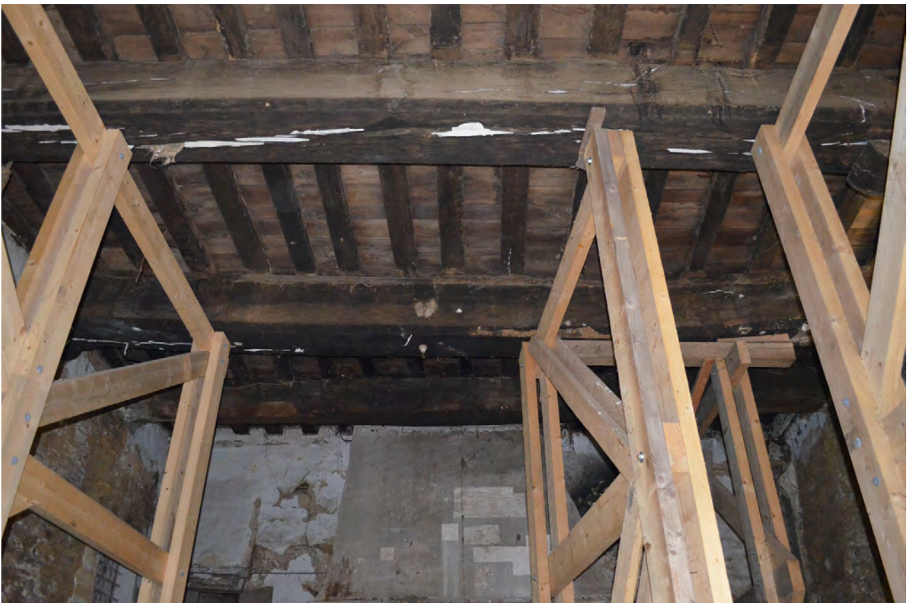
Fig.3 L'étaieement intérieur © E. Esnault, Inrap
