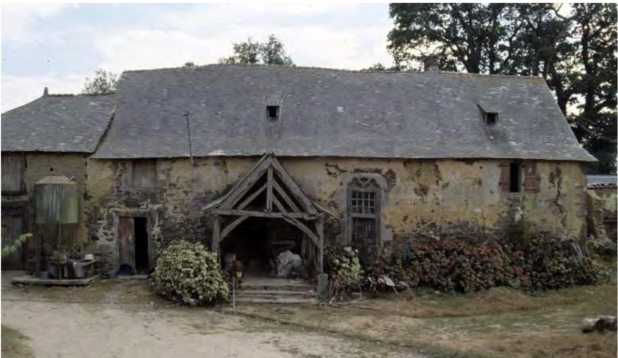
Fig.138 Le petit bâtiment ouest en cours de destruction © Guy Artur et Norbert Lambart Inventaire général, ADAGP
