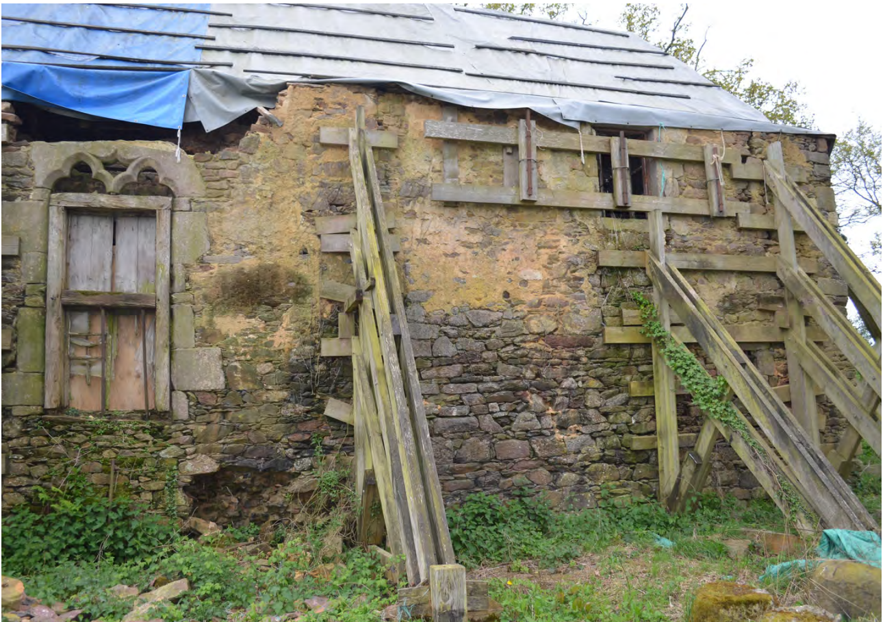
Fig.2 L'étaieement extérieur © E. Esnault, Inrap
