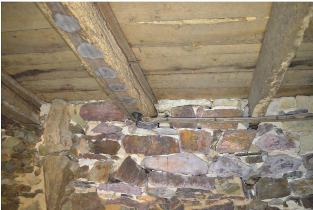
Fig.64 La réparation du solivage © E. Esnault, Inrap
