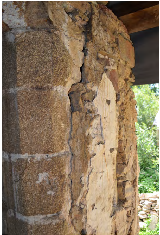
Fig.113 La porte de la chambre orientale en partie bûchée lors de l'installation de l'escalier à vis © M. Millet, Inrap
