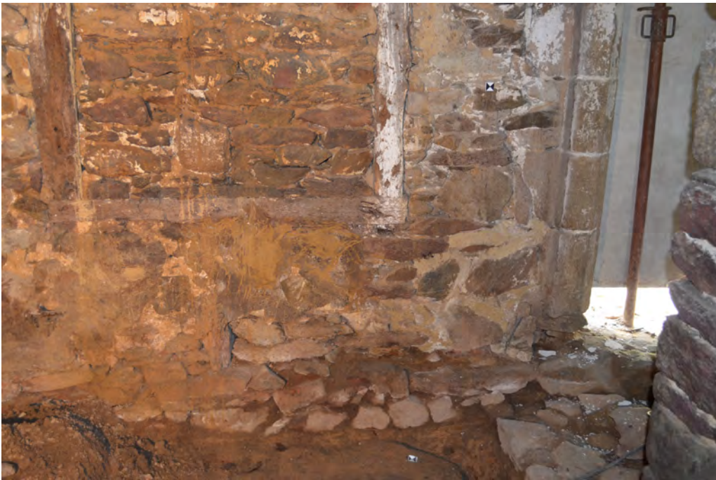
Fig.52 La réservation pour le battant de porte © M. Millet, Inrap
