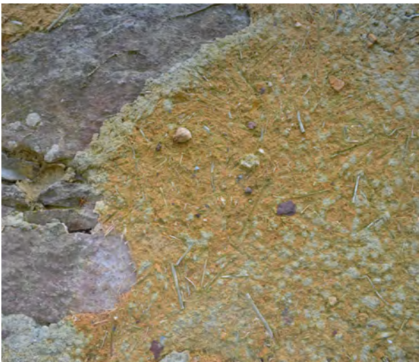
Fig.8 L'enduit 1005 © E. Esnault, Inrap
