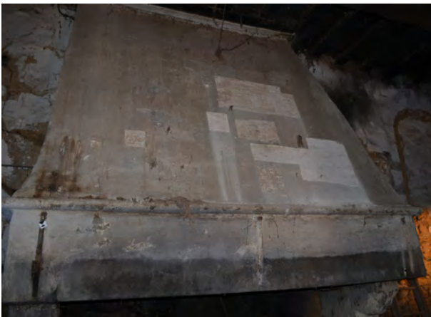
Fig.39 Les deux enduits de faux-appareils © R. Battais, Inrap
