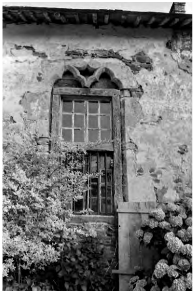
Fig.136 La croisée modifiée par l'ajout d'une carrée de bois © Y. Desdoigts, Inventaire général, ADAGP, 1974
