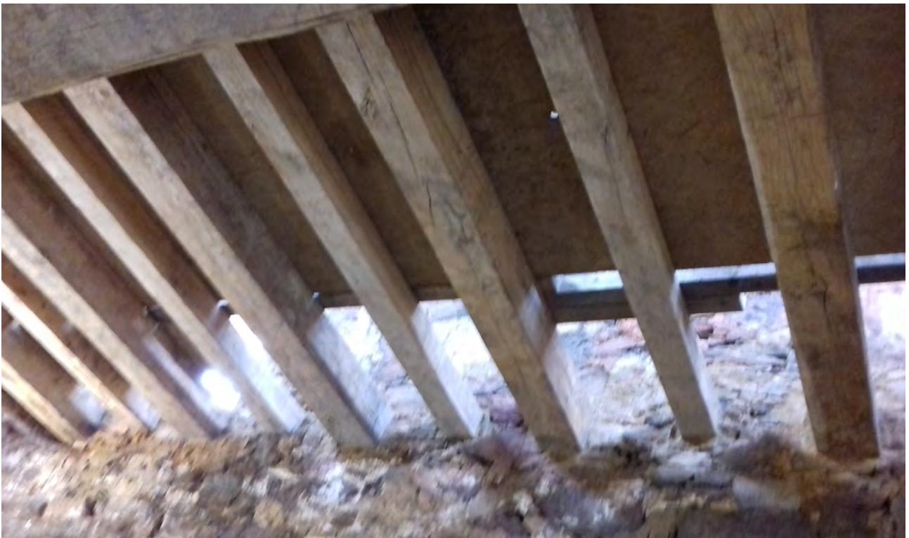
Fig.139 Le plancher de la cuisine remplacé © E. Esnault, Inrap
