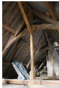
Corps principal, charpente de comble : 4e ferme depuis l'ouest
