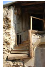
Corps principal, escalier sud-est vu depuis le sud
