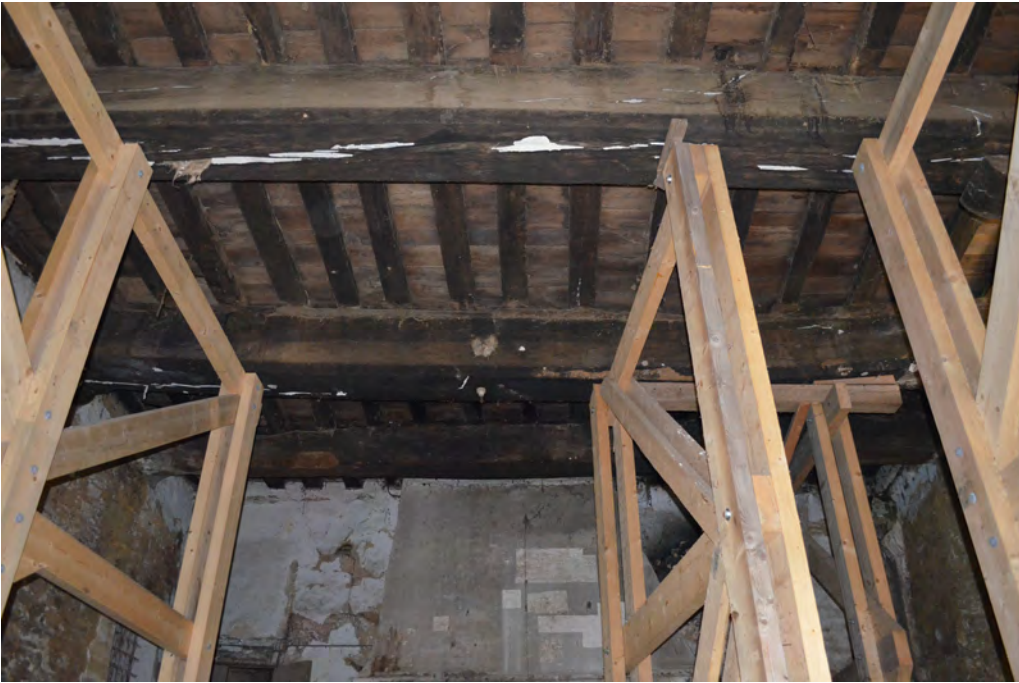
Fig.44 Le plancher 1113 et l'ancrage des poutres © E. Esnault, Inrap
