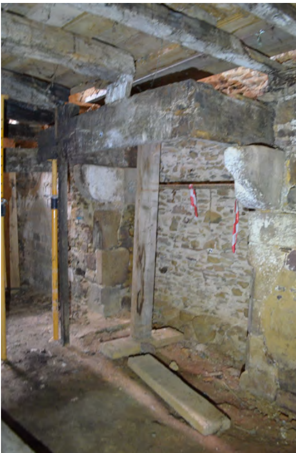
Fig.54 La cheminée © E. Esnault, Inrap
