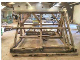
Chapitreau, charpente de couverture versant est
