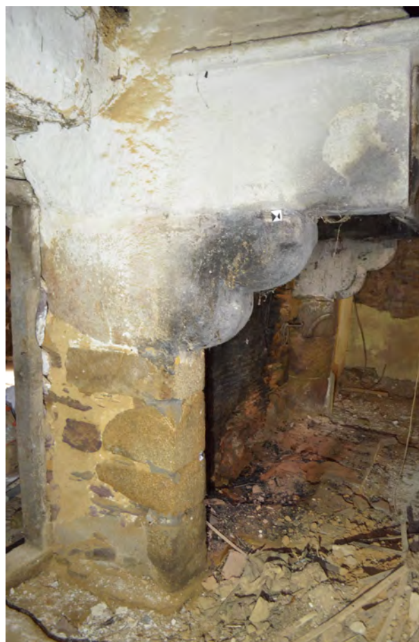
Fig.49 La modification du piédroit de cheminée © E. Esnault, Inrap
