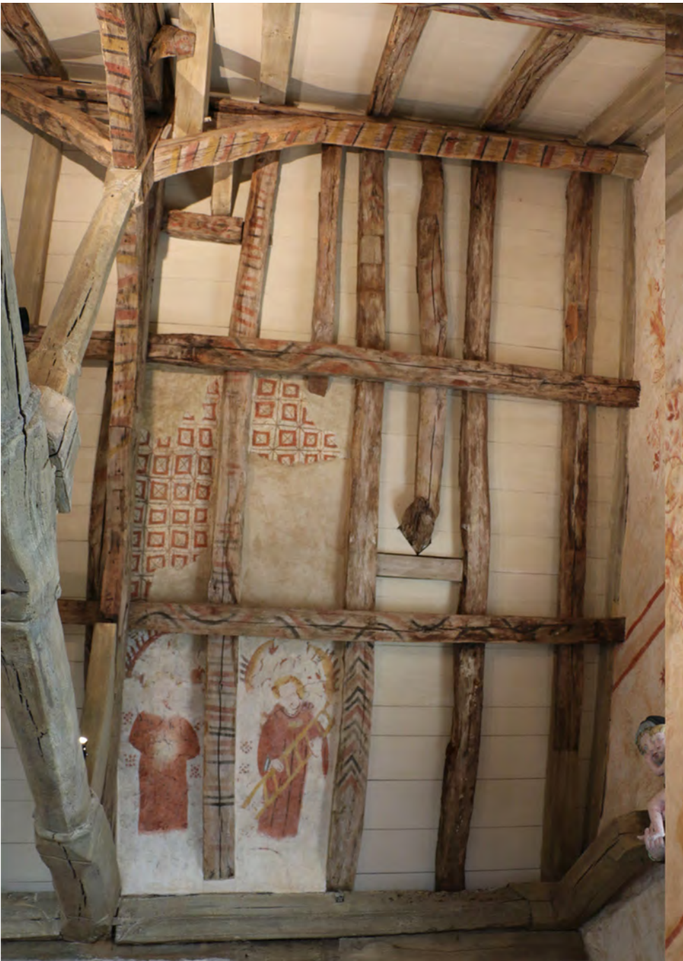
Fig.108 Exemples d'enduit entre chevrons : chapelle Notre-Dame de Locmaria à Nostang (56) © C. Olivier
