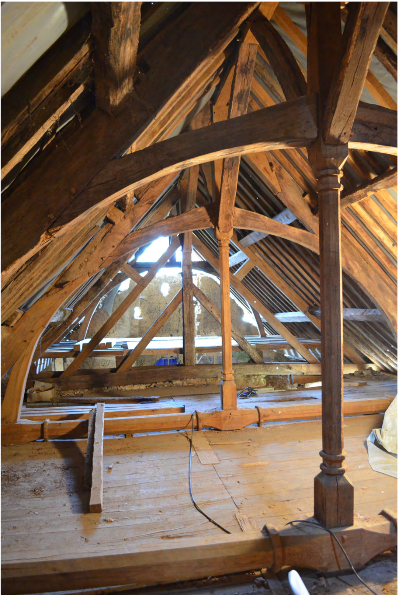
Fig.30 La charpente, vue générale © M. Millet, Inrap
