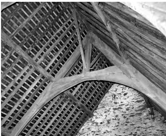
Fig.106 Exemple de fermes à faux-entrail droit, poinçon court et liens et jambettes cintrés : le manoir du Pont à Renac (35) © G. Artur, N. Lambart, Y. Carpentier, Inventaire général, ADAGP
