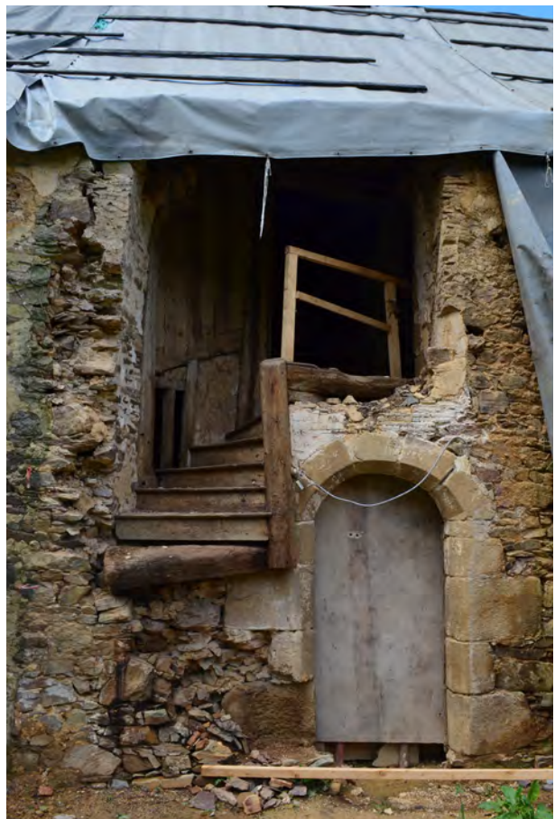
Fig.114 L'escalier © E. Esnault, Inrap
