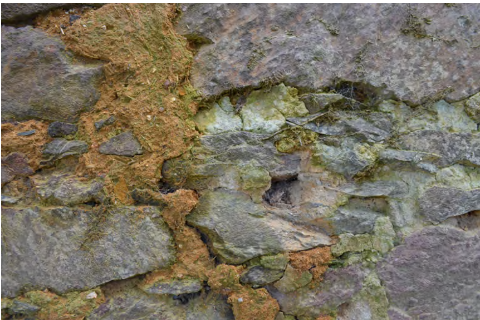
Fig.6 L'enduit 1026/1057 © E. Esnault, Inrap
