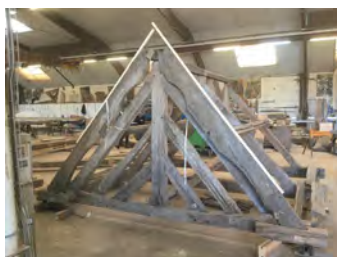
Chapitreau, charpente de couverture vue de la ferme nord
