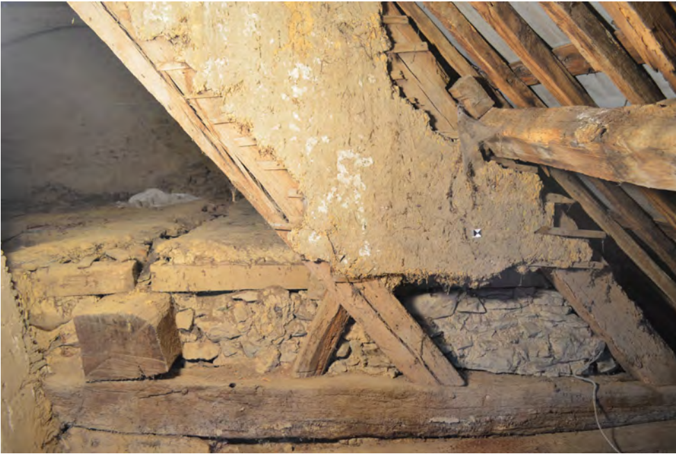
Fig.35 Le hourdis des fermes-cloisons © M. Millet, Inrap
