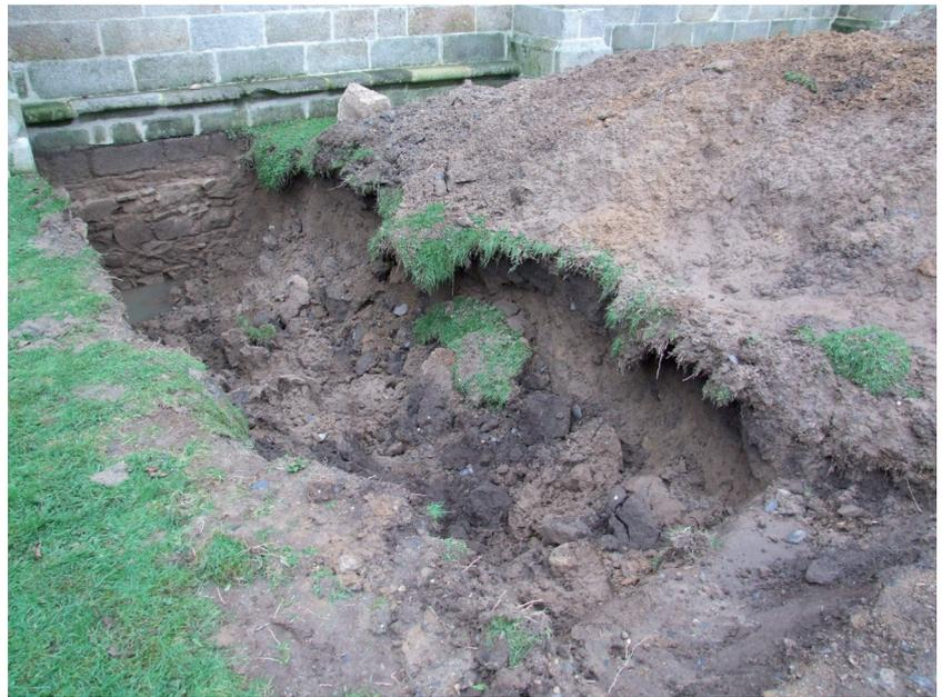
**Fig. 10** Effondrement des coupes. Sondage 3, coupes entièrement effondrées. Sondage 6, deux photos à moins d'une minute d'intervalle.
