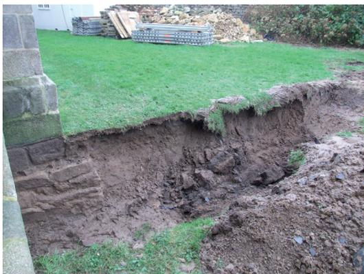
Fig. 21 Effondrement des coupes du sondage 2.
