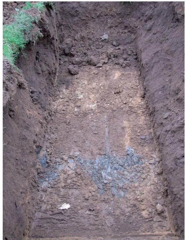
Fig. 31 Premier niveau de circulation Us 5005 (à gauche, liseré jaune-orangé à la base de la coupe), Us 5015 (à droite avec ces ardoises).
