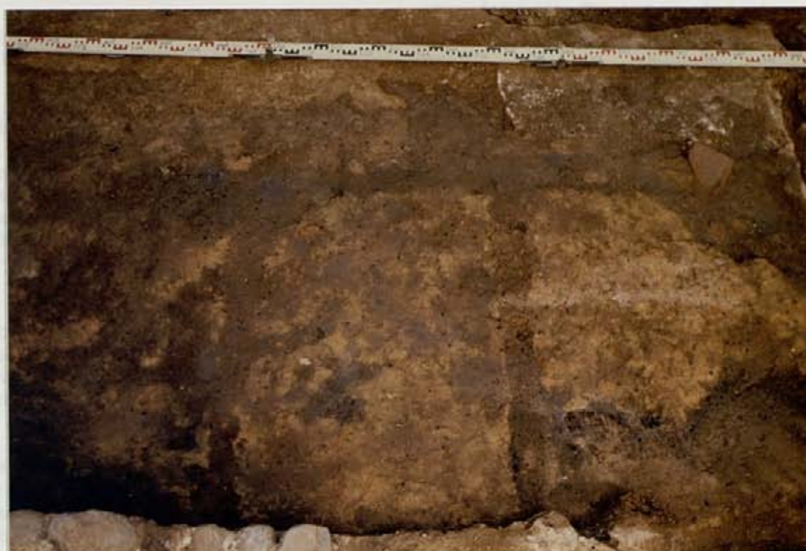
Photo 12 : Traces de lambourdes de plancher dans la pièce 1
