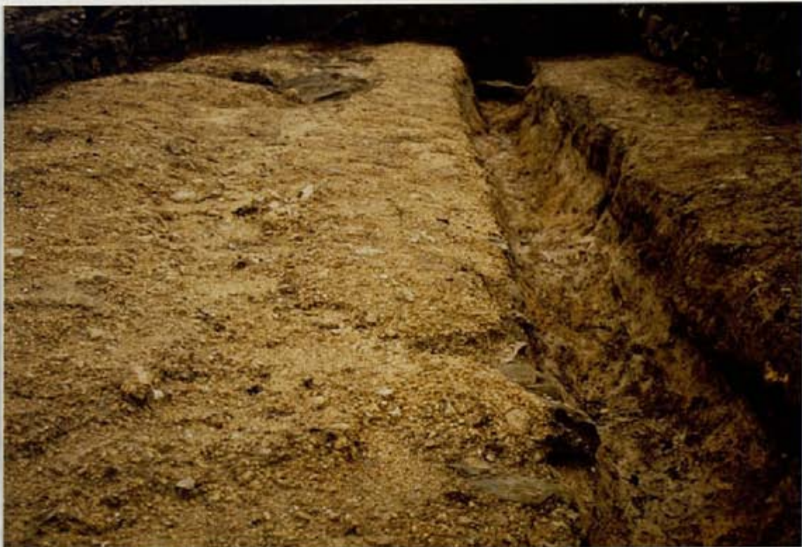
Photo 5 : Chaussée de la voie de la phase I
