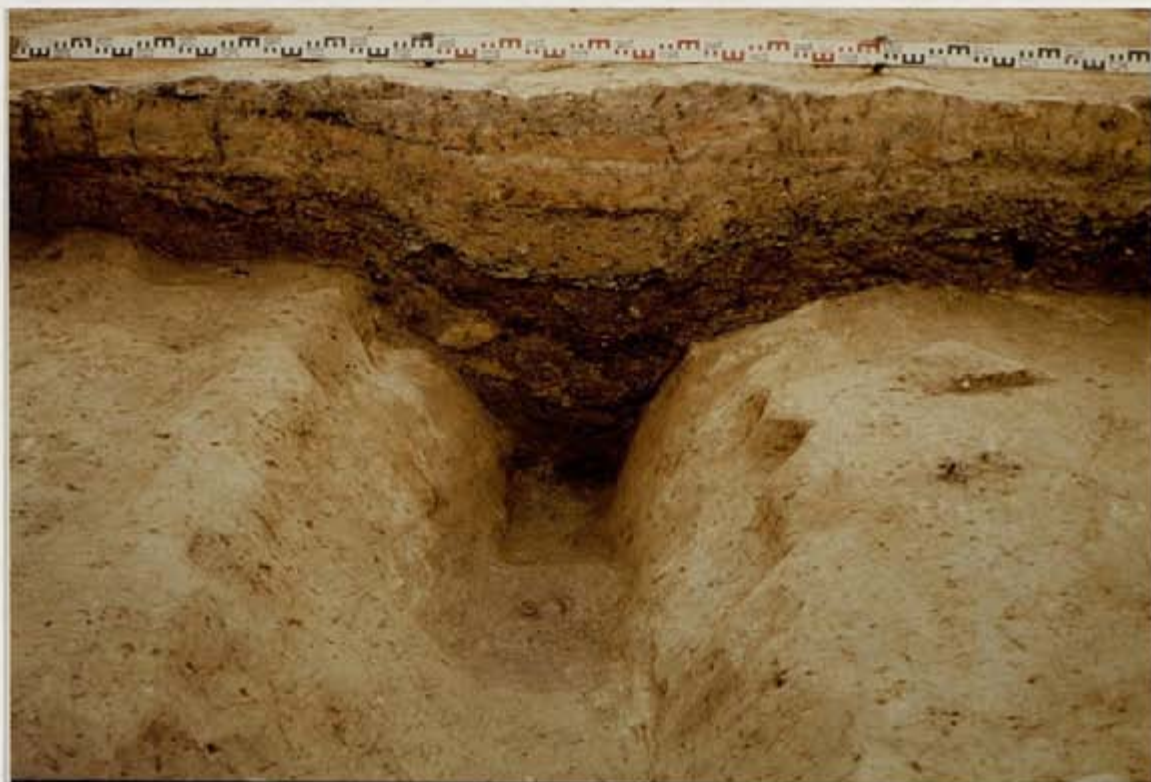
Photo 7 : Affaissement des sols des premiers bâtiments au dessus du drain d'assainissement.
