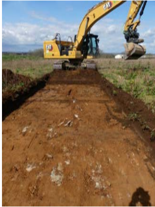
fig.11. Pelle mécanique de 20t terrassant une tranchée
