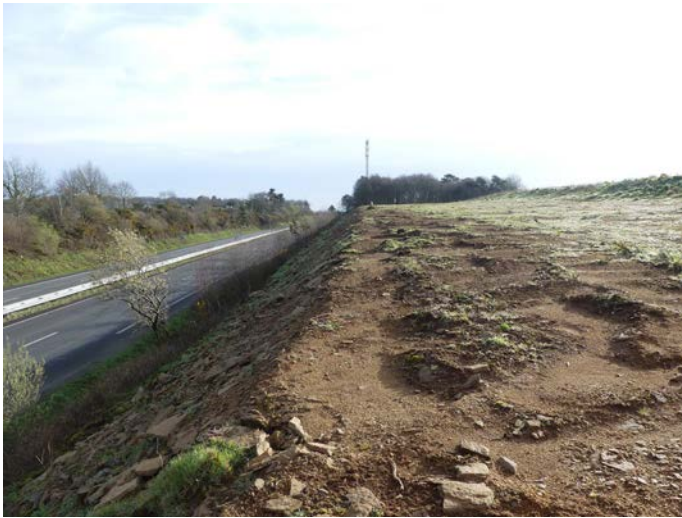
fig.4. Vue de la bande décapée au Nord le long de N24.
