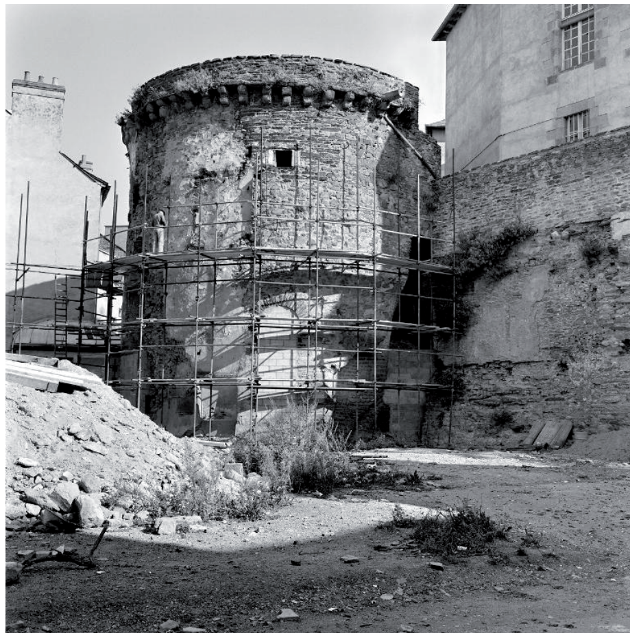
Restauration de la tour Duchesne, septembre 1966 (C. Barmay, photographe, Rennes musée de Bretagne)
