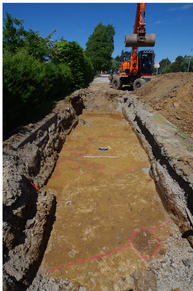
Figure 32 : Photographie de F 09.08, au premier plan (cliché A. Kergourlay)
