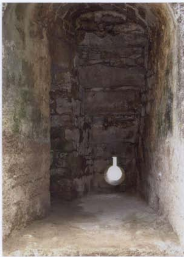
Figure 90 - Vue de la canonnière sud, base de la tour ouest (T. Béthus, Inrap).
