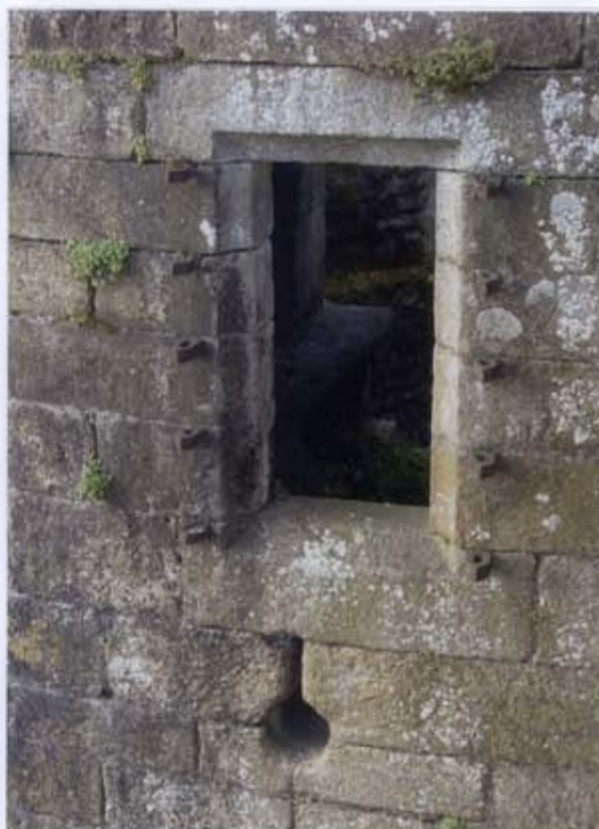
Figure 95 - Vue de la tour ouest, élévation extérieure de la baie est (T. Béthus, Inrap).
