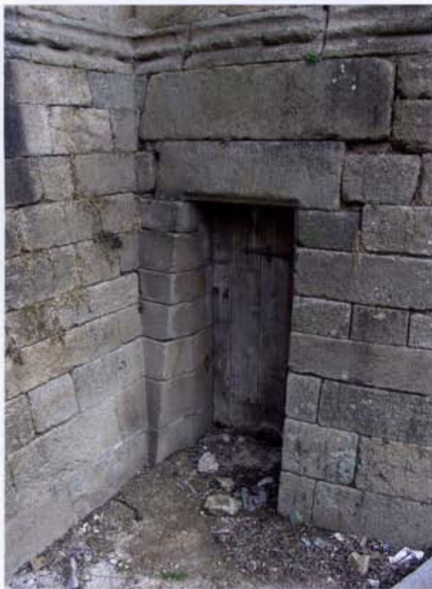
Figure 96 - Vue de la tour est, poterne sud (T. Béthus, Inrap)
