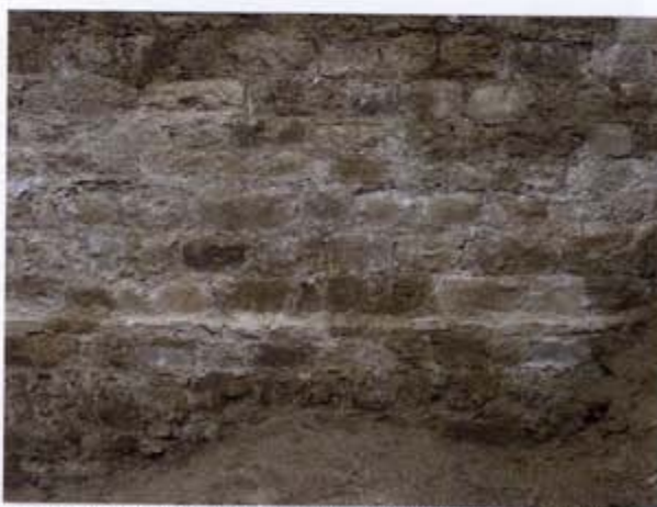
Figure 79 - Vue du ressaut à la base de l'élévation nord-ouest.
