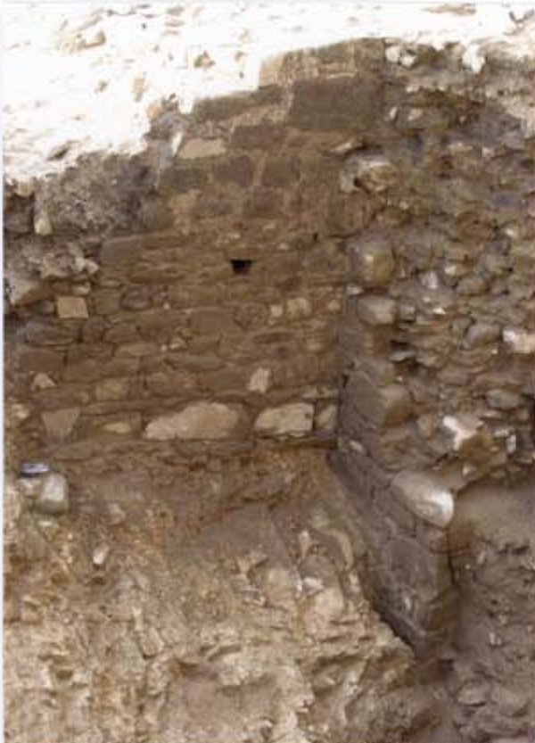
Figure 18 - Zone 2, secteur 8, vue du contrefort 2047 et du bord du fossé 2048 (L. Beuchet, Inrap).
