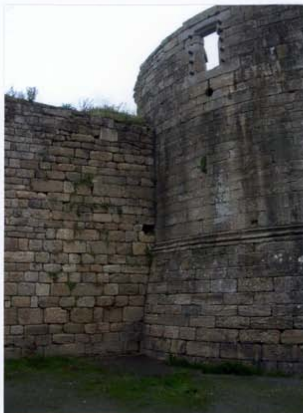
Figure 108 - Vue du mur actuel de soutènement des remblais modernes, collé contre la tour ouest (L. Beuchet, Inrap).
