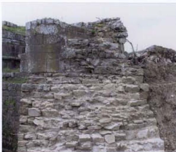
Figure 92 - Vue des vestiges du rez-de-cour de la tour ouest (L. Beuchet, Inrap).
