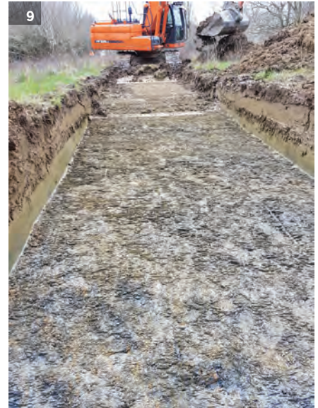
Fig. 9 Exemple de tranchée de diagnostic décapée à la pelle mécanique © Y. Escats
