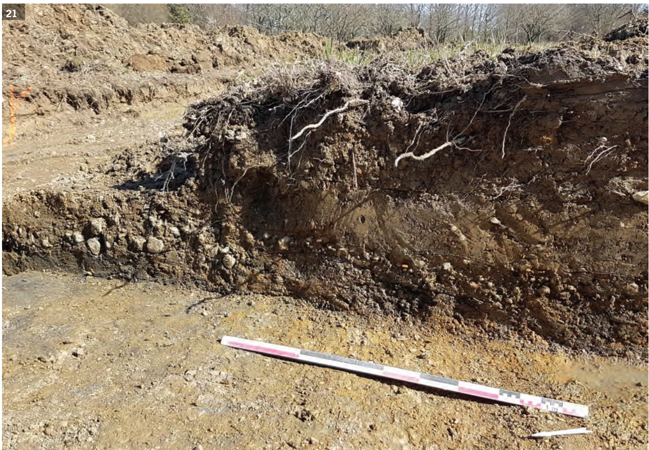
Fig. 21 Détail de la coupe du chemin 36-3, le cailloutis composé de quartz roulé de différentes dimensions © Inrap, Y. Escats
