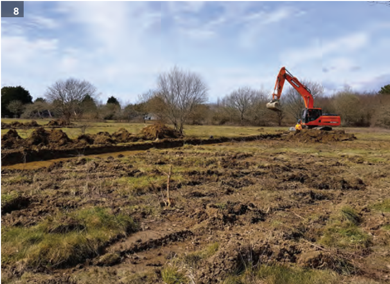
Fig. 8 Tranchées de diagnostic en cours de décapage à la pelle mécanique © Y. Escats
