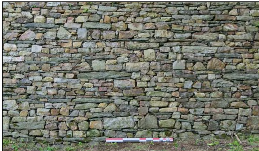
Fig 15 : vue partielle du parement extérieur de la courtine correspondant au relevé pierre à pierre
