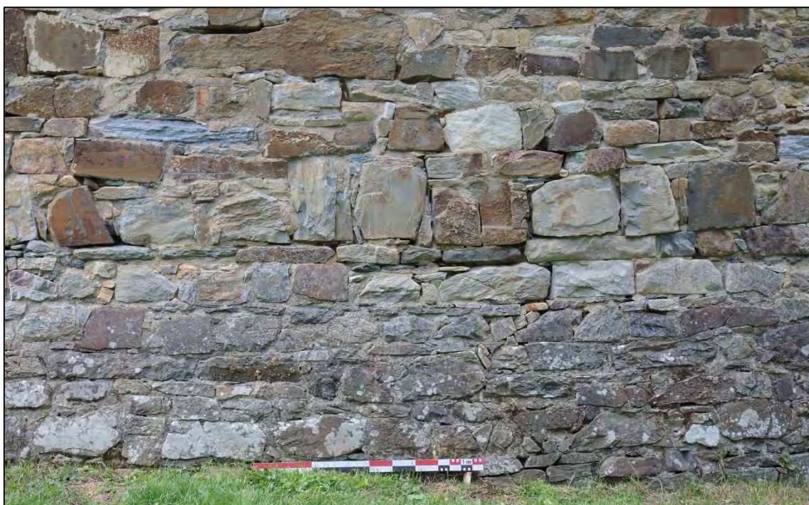
Fig 23 : vue de la partie du parement de la base de la tour maîtresse correspondant au relevé
