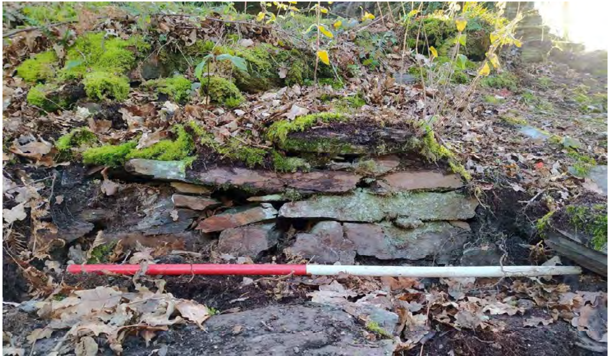
Fig.14 : parement du muret 2
