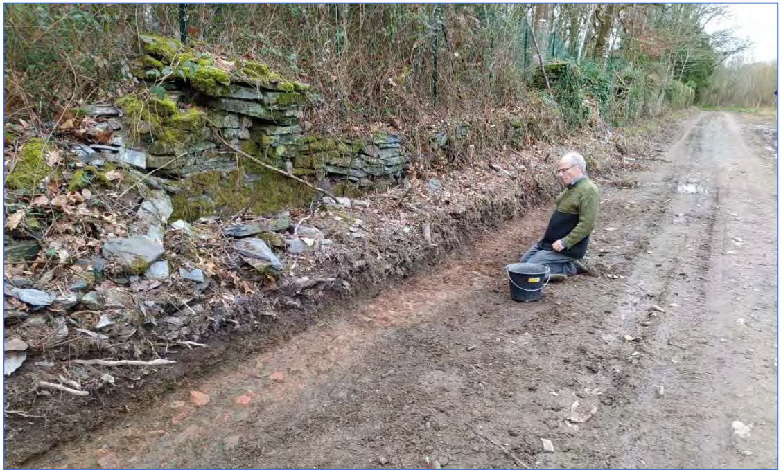
Fig. 5 : vue de la partie décapée en cours de nettoyage
