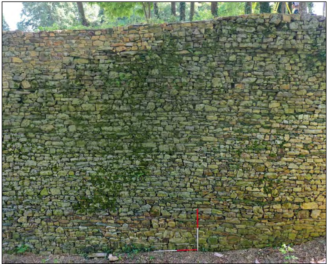
Fig 13 : vue partielle du parement extérieur de la courtine (H) avec partie restaurée à son sommet (photo Jean-Jacques Blain)
