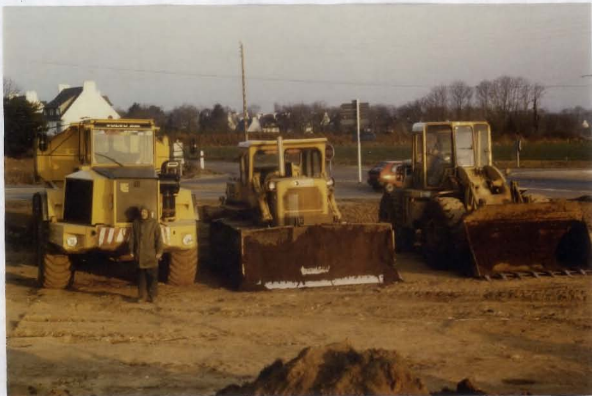
Engins de décapage bloqués par les intempéries.
