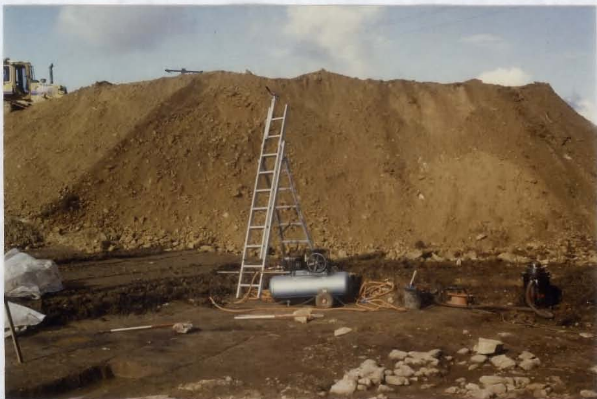
Fouille de la voie sous les remblais de chantier routier.
