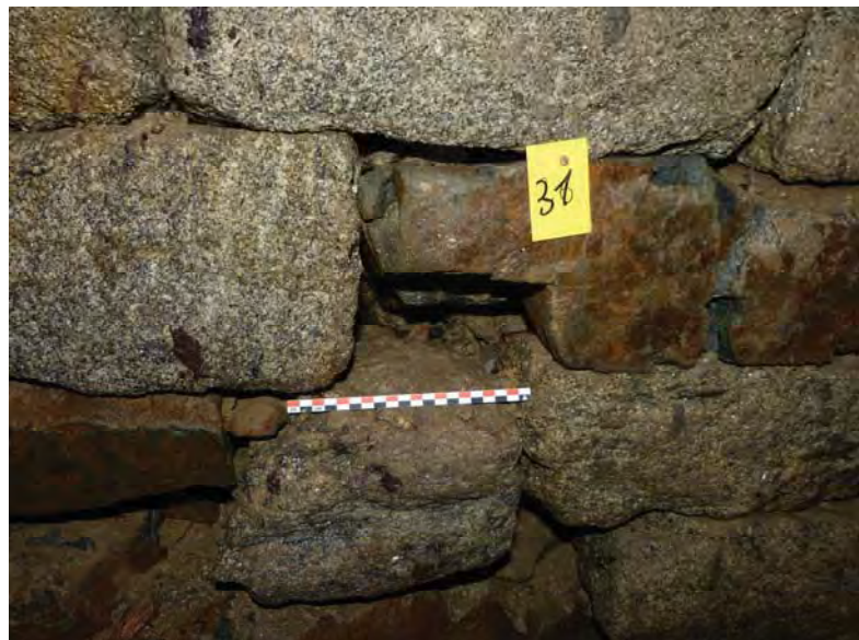
Fig. 5. Assise de réglage et première des marches. Détail du parement nord du puits à environ 11,20 m NGF. Cliché J.-M. Féménias.
