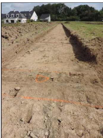
Fig. 8 : Vue générale de la tranchée 1
