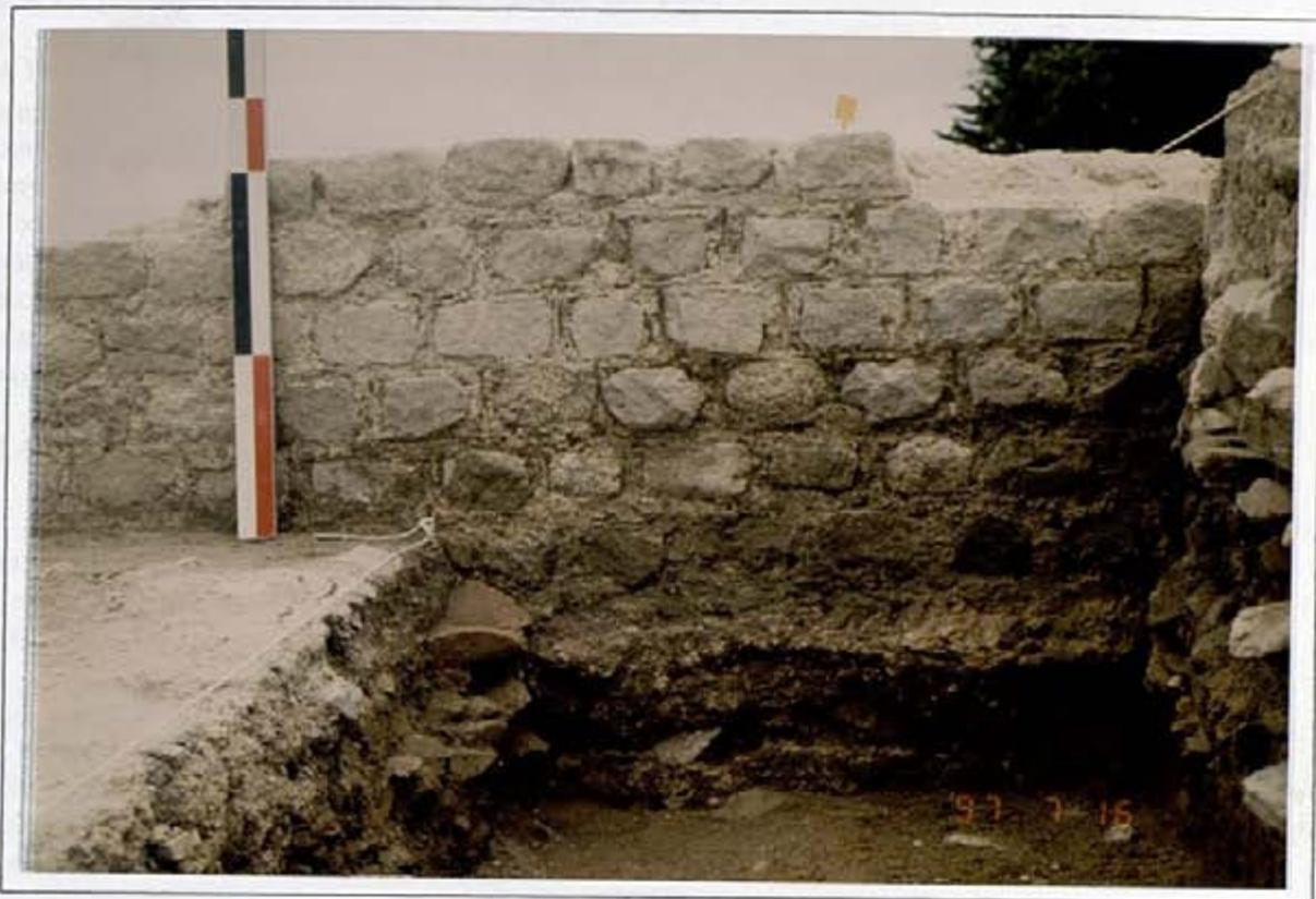
Fig. 72: Fondation et parement externe du péribole du portique latéral nord au niveau du sondage S82
