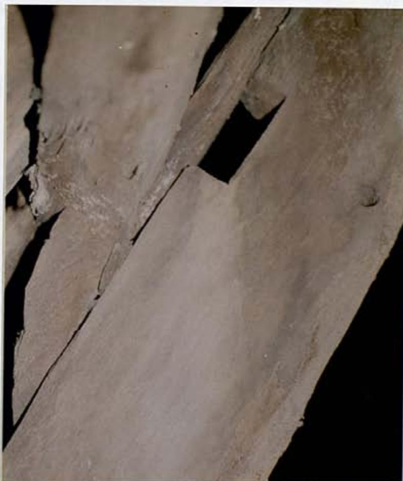
**Fig. 42** : Panne retenue par chantignolle ; entaille dans l'arbalétrier non utilisée
