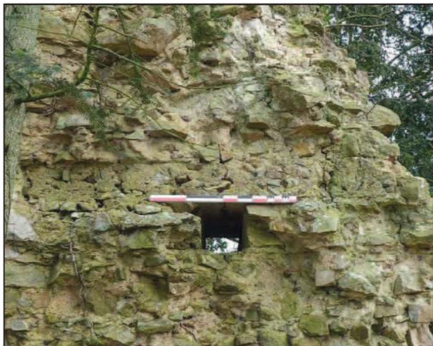
Photo 19 : Emplacement des poutres au niveau de l'arrachement de la maçonnerie de la tour (UC 1, UC 2)
