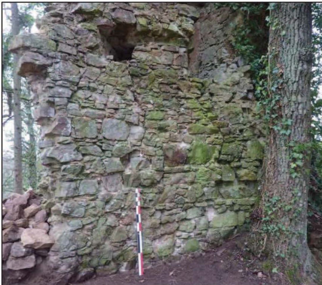
Photo 17 : Parement intérieur niveau 1
