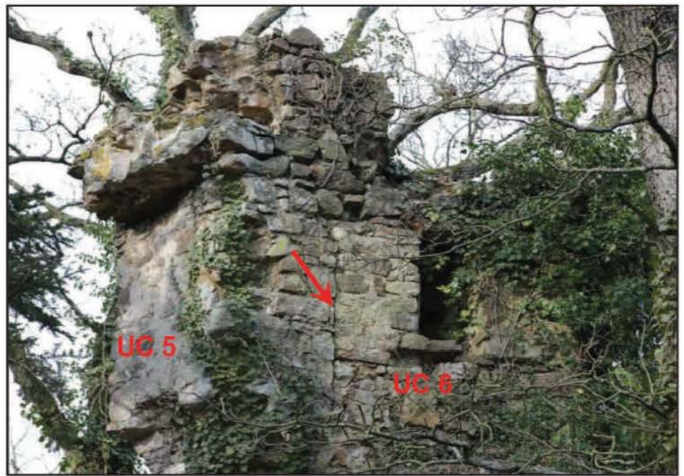
Photo 27 : Ouverture UC 5 et archère UC 6 comblée dans le niveau 3 de la tour La flèche indique la limite de l'archère initiale
