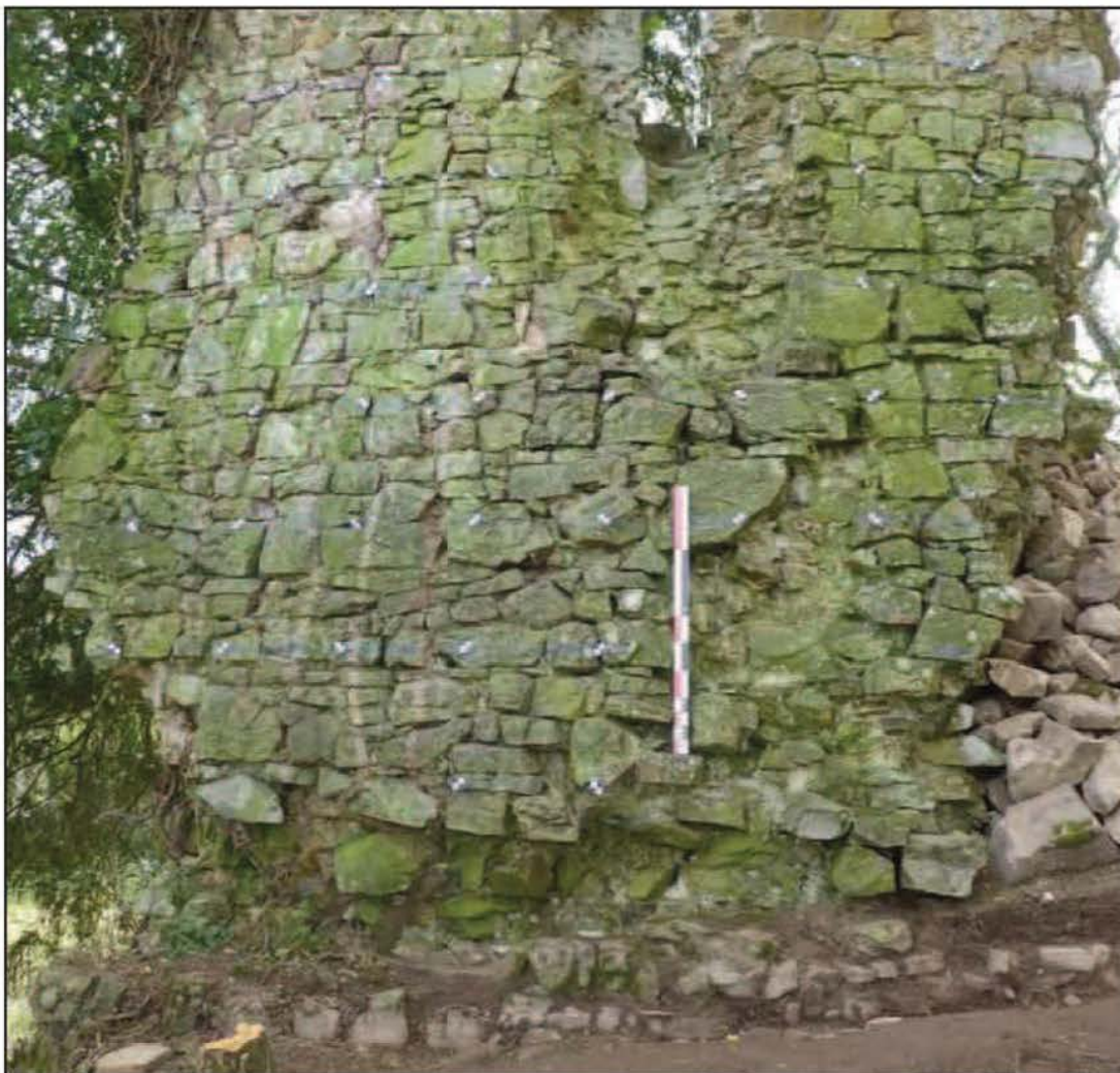
Photo 18 : Parement extérieur niveau 1
