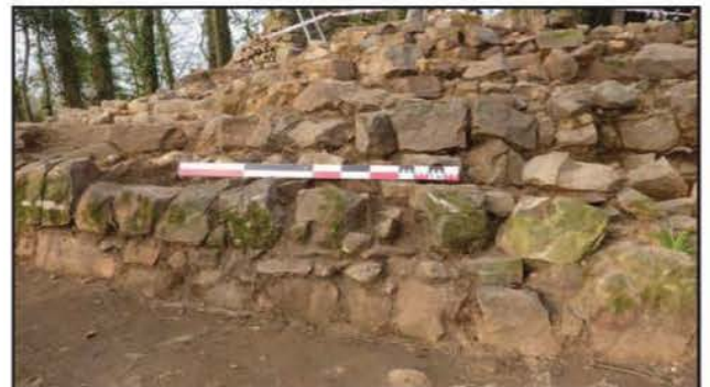
Photo 9 : Parement extérieur dégagé
