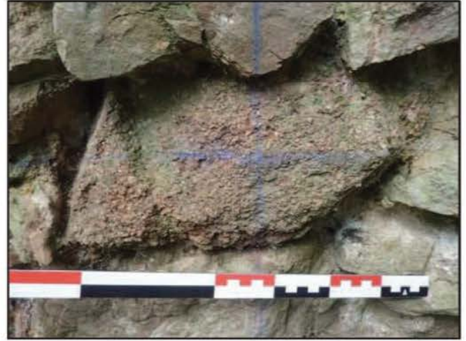
Photo 29 : Bloc de granit dans le parement intérieur de la tour
