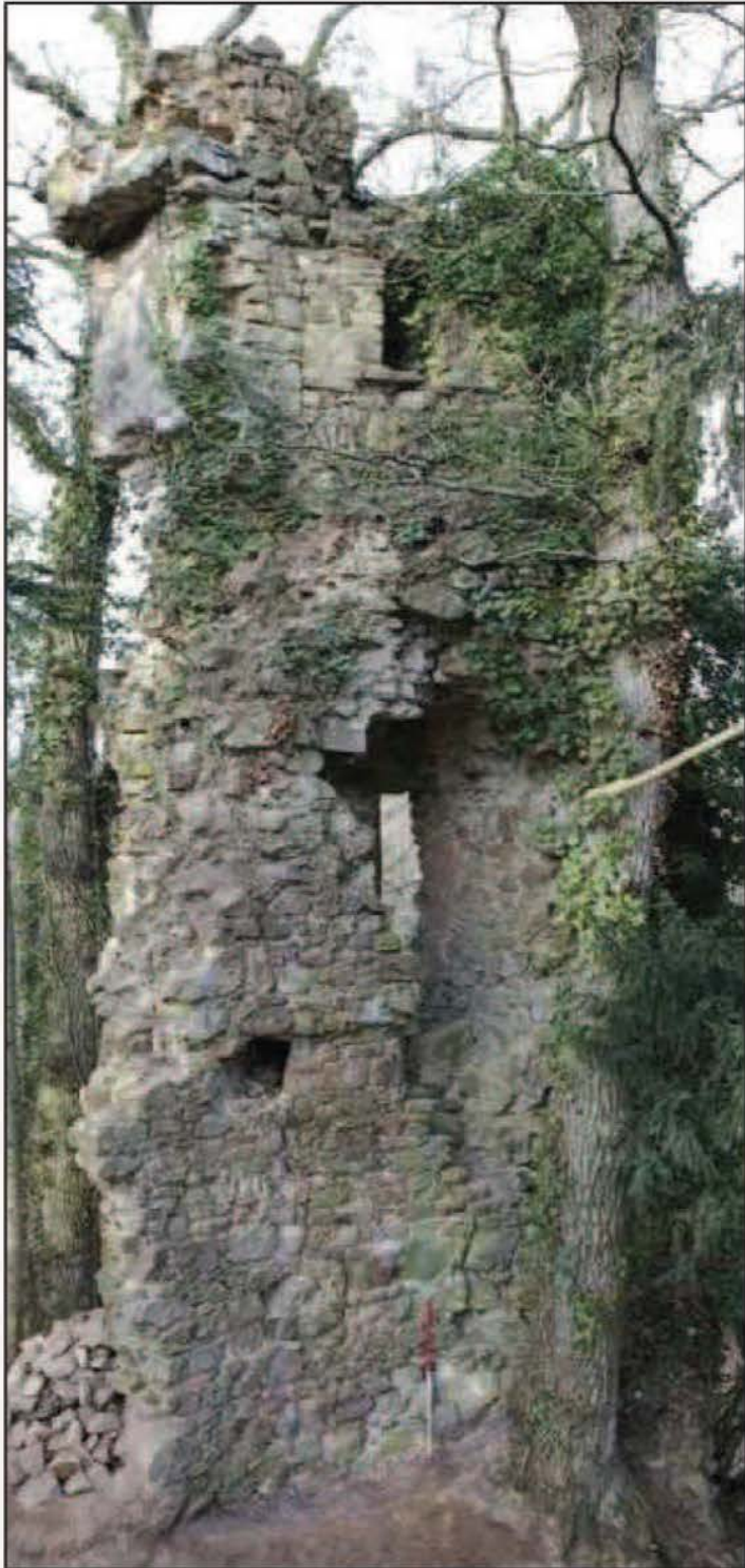
Photo 15 : Parement intérieur de la tour
