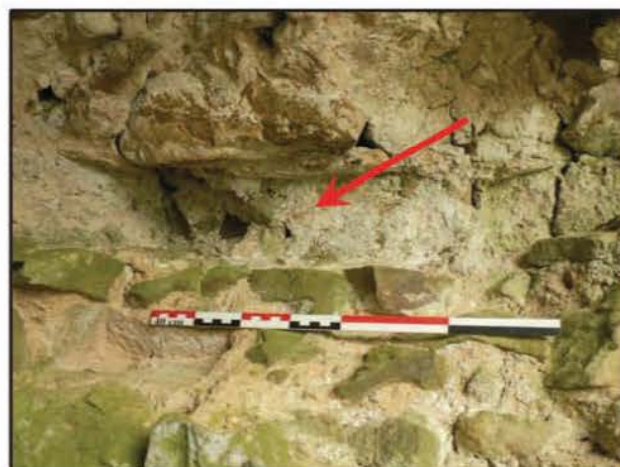
Photo 23 : Emplacement de poutre dans la partie supérieure de l'archère (UC 3)
