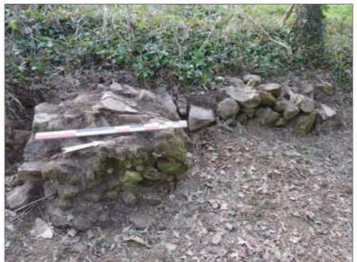
Photo 44 : Reste de parement à l'ouest du fossé (à droite) et élément de la tour roulé dans le fossé (à gauche)
