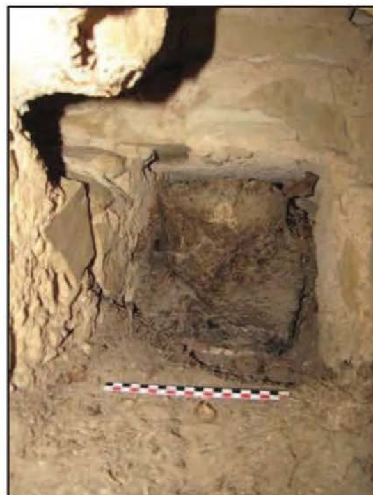
Photo 21 : Poutre bois en place (UC 1)
