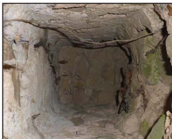
Photo 22 : Négatif de poutre dans la maçonnerie (UC 2)
