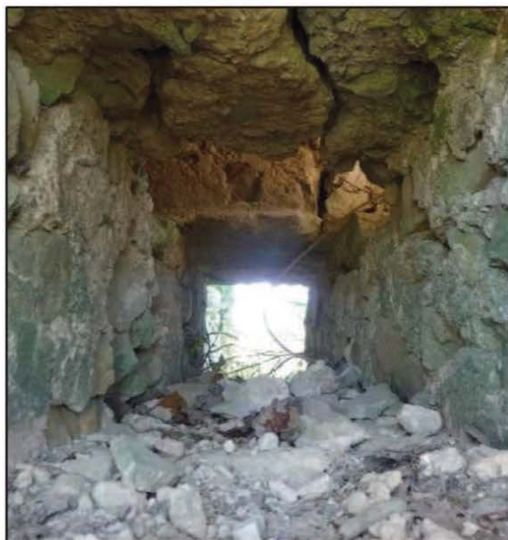
Photo 20 : Emplacement des poutres dans la maçonnerie intérieure de la tour (UC 1, UC 2)
