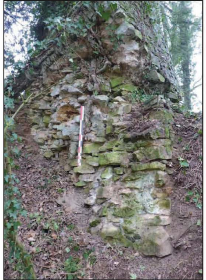
Photo 12 : Fondation et parement extérieur de la tour
