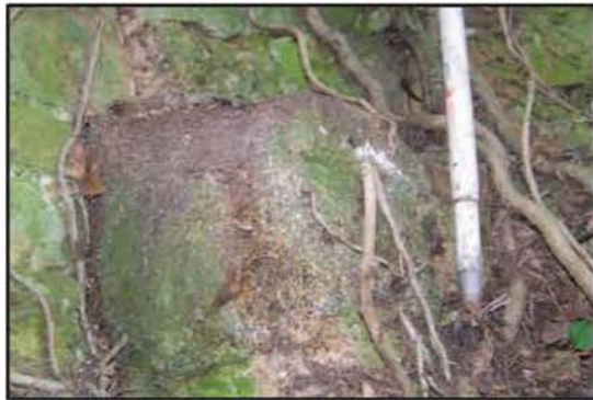
Photo 30 : Élément de marche en granit de l'escalier
