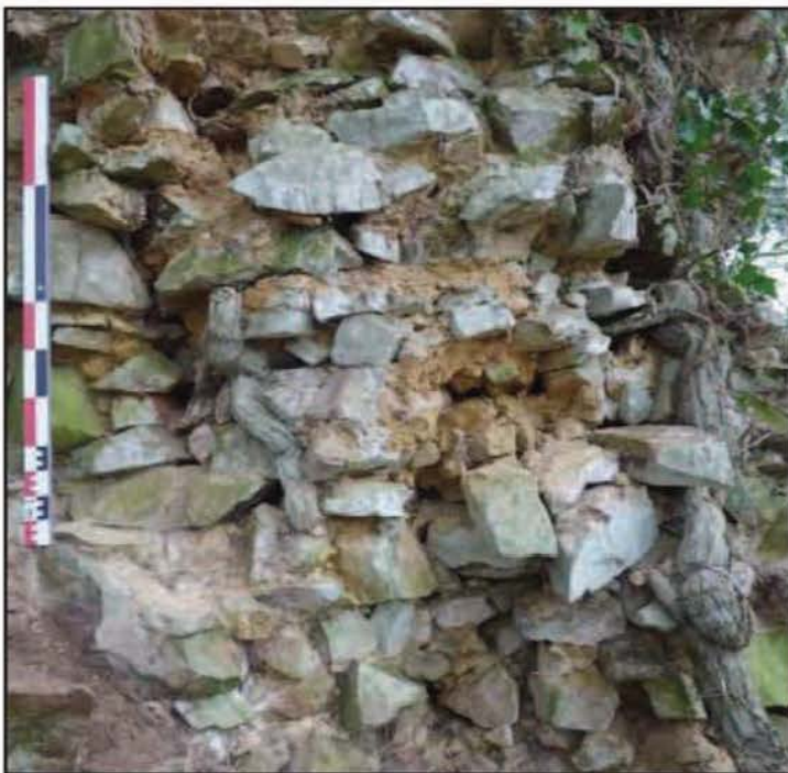
Photo 13 : Blocage interne de la fondation de la tour
