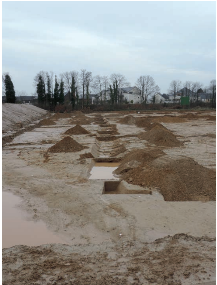
F. 2 Vue vers l'ouest, après curage du fossé
