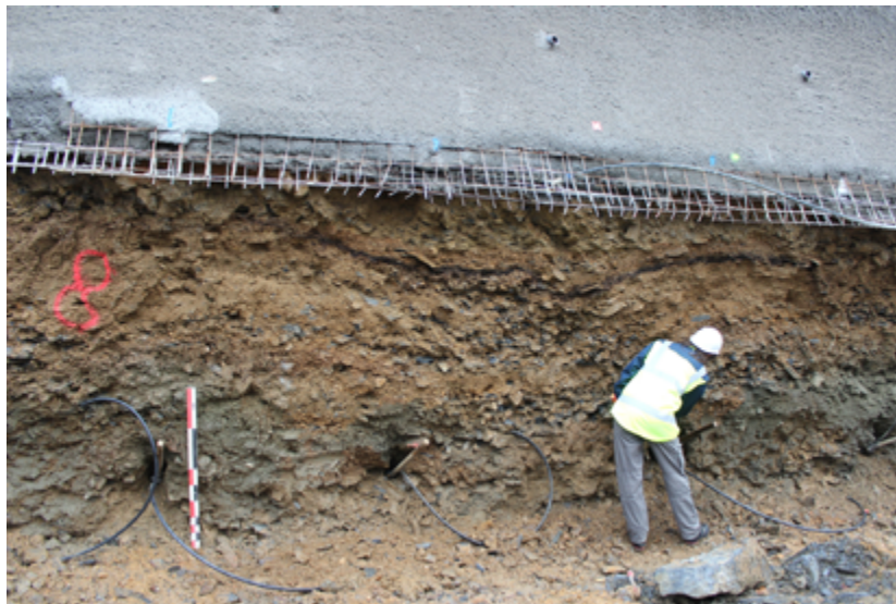
Fig. 18 - Relevé des remblais sous la paroi en béton projeté
