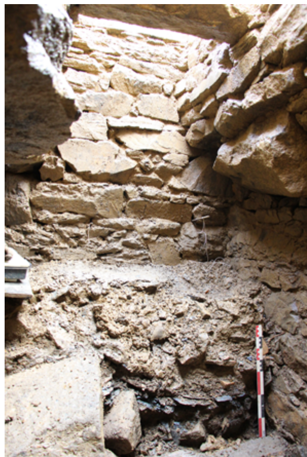
Fig. 83 - Paroi sud de la fosse des latrines
