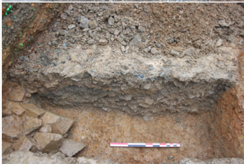
Fig. 175 - SD12. Sous le remplissage de F3, apparaissent les rares blocs oubliés de la fondation de la tour sud-est
