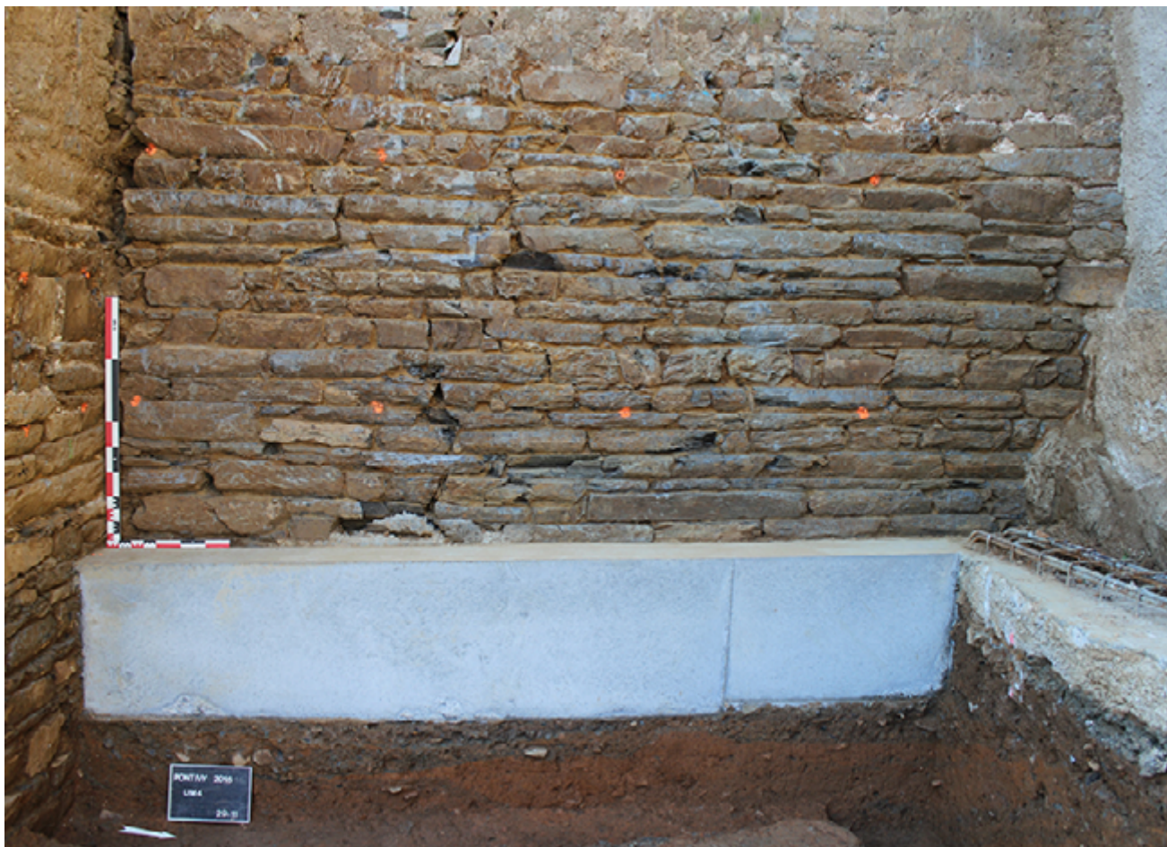
Fig. 48 - Mur pignon ouest (M4), parement oriental
