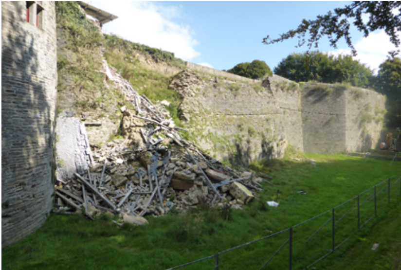
Fig. 16 - Cône de démolition de la courtine sud (cliché Jocelyn Martineau)
