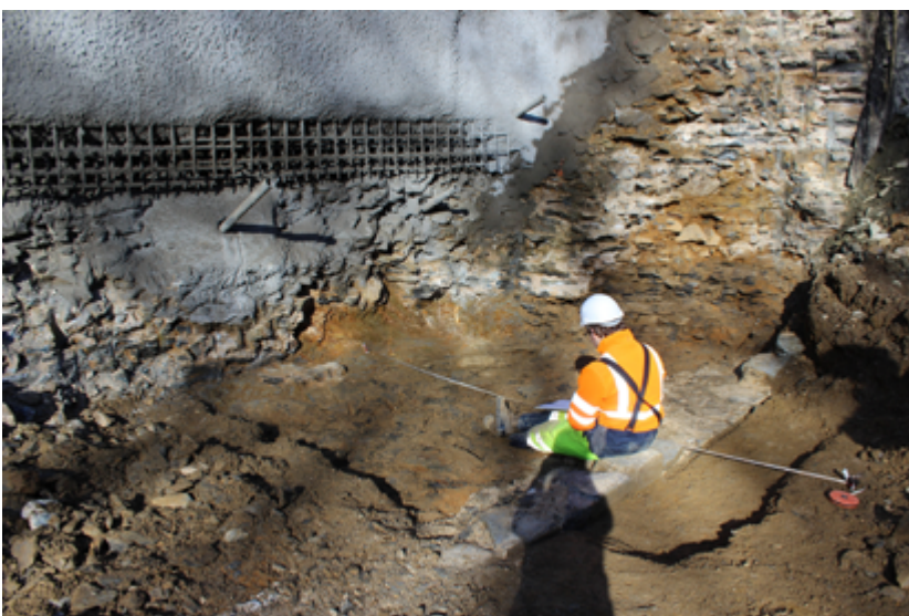
Fig. 19 - Relevé en cours du mur de la courtine sud
