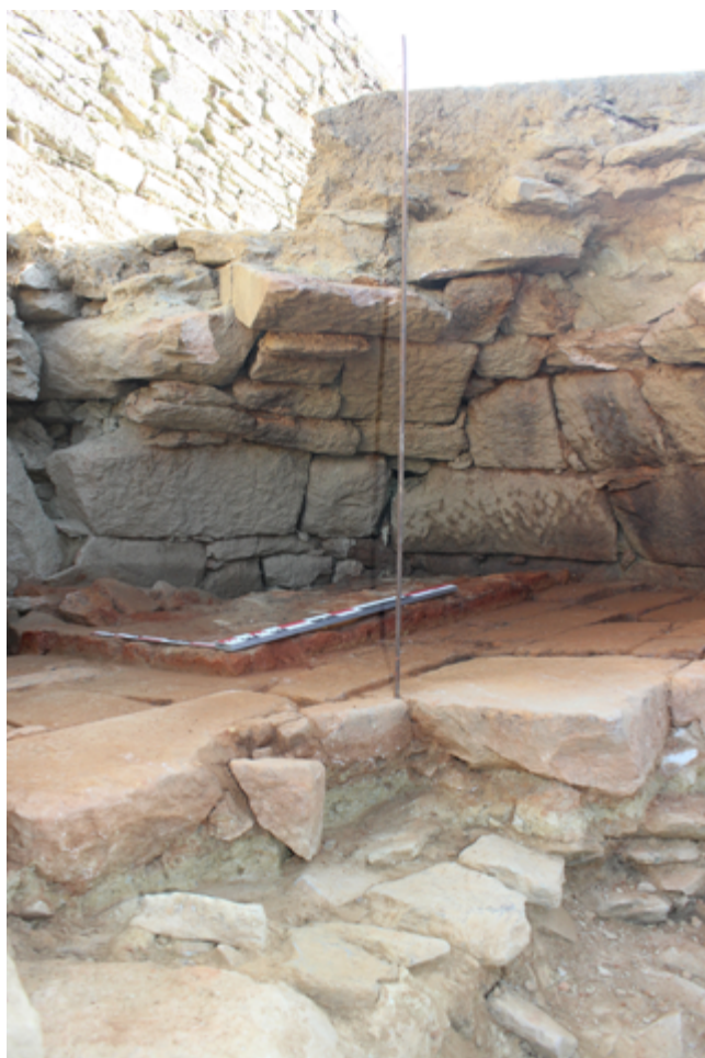
Fig. 58 - Stratigraphie d'aménagement de la sole avec un radier de pierres, un lit de pose d'argile puis la sole en granite (vue depuis le sud-ouest)
