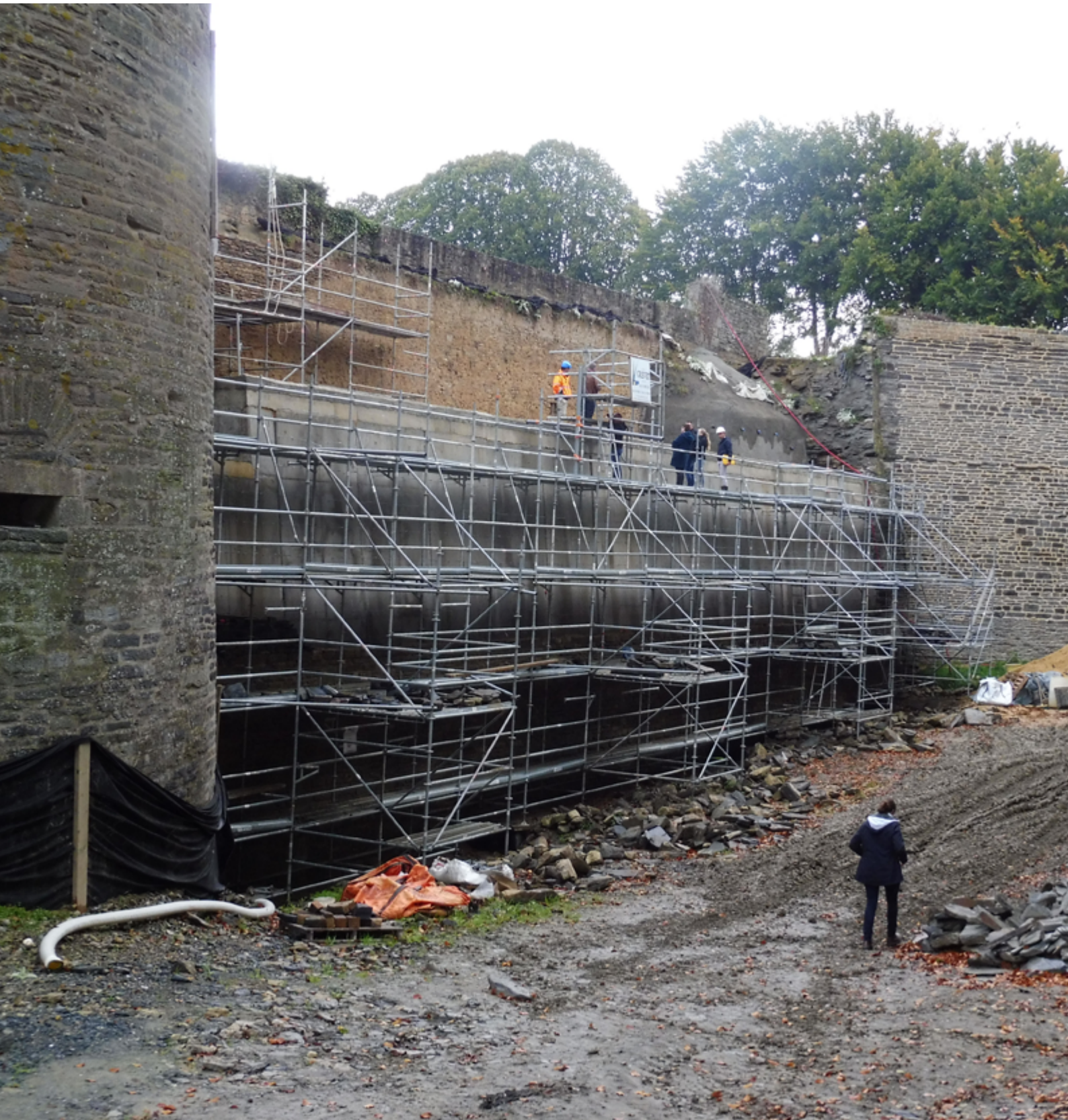
Fig. 40 - Travaux de reconstruction de la courtine sud en cours (hiver 2017)
