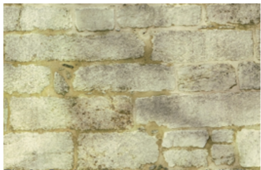
Fig. 2 - Granite utilisé en parement de l'orillon sud du bastion
