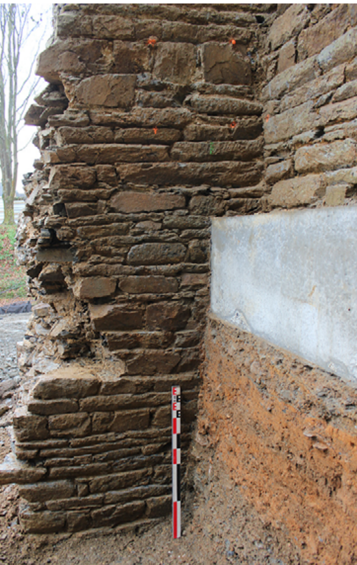
Fig. 45 - Parement interne de M2 (rares vestiges de la partie non effondrée du mur)
