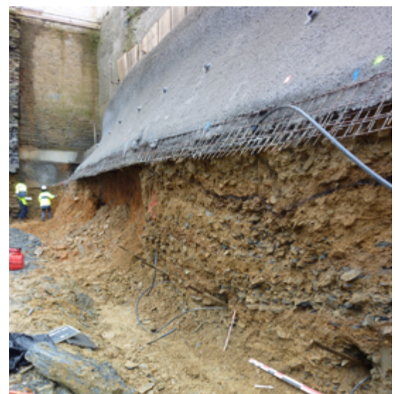
Fig. 20 - Observation des remblais de la courtine sud sous la paroi en béton projeté
