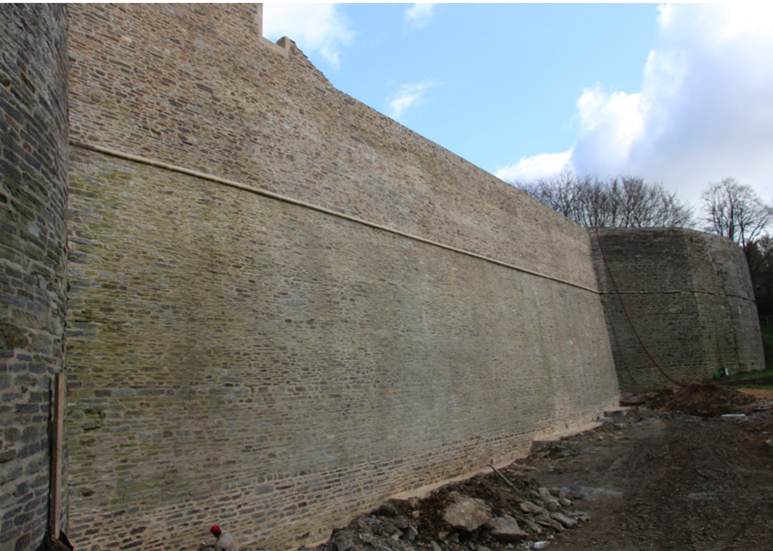
Fig. 68 - Achèvement des travaux de reconstruction de la courtine sud (mars 2019)
