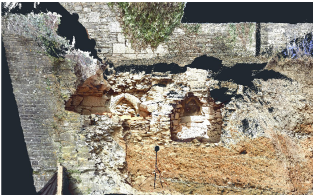
Fig. 21 - Aperçu du scan 3d des fours à pain découverts dans la courtine sud
