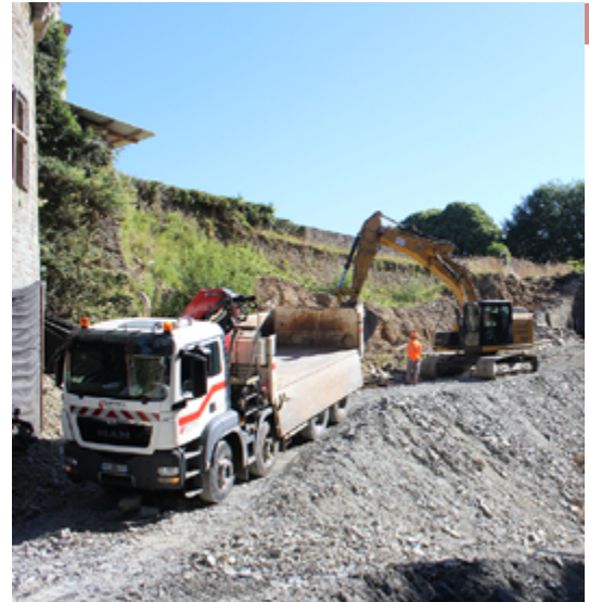
Fig. 17 - Travaux de déconstruction en cours
