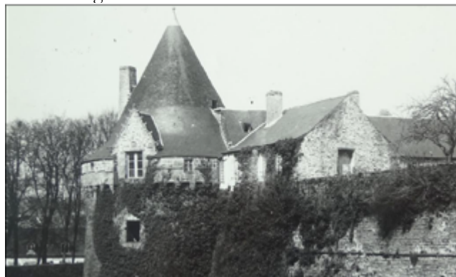
Fig. 66 - «Cabinet de Monseigneur» construit au sommet de la courtine sud (photographie datée des années 1930 - Arch. mun. Pontivy, 2 Z 242)
