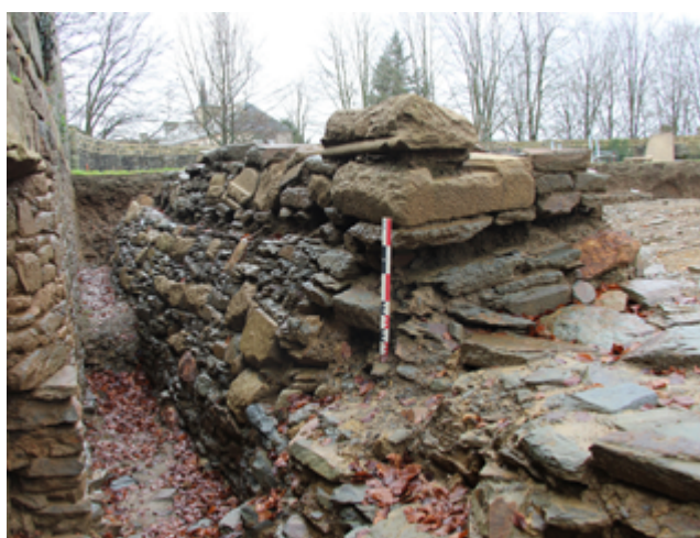
Fig. 114 - Mur M7 (vue depuis le nord)
