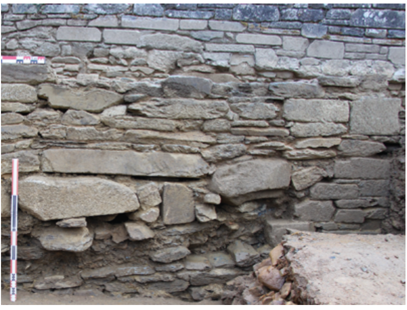
Face ouest de M9
