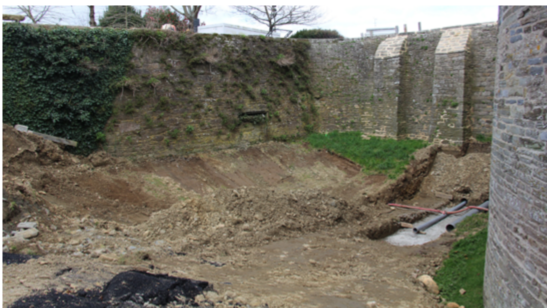
Fig. 23 - Travaux en cours dans la douve ouest
