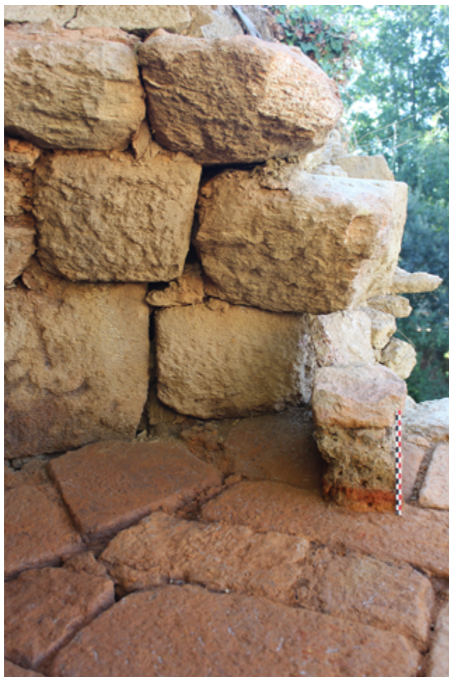
Fig. 59 - Vue de la sole et de la coupole en grandes pierres de taille de granite
