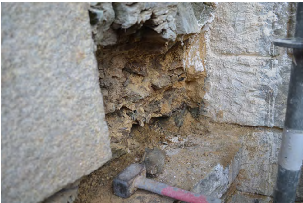
Fig.114 La relation chronologique entre l'aile est de la bastille et la tour est © E. Esnault Inrap. Le parement du glacis s'appuie sur le blocage du mur de bastille.
