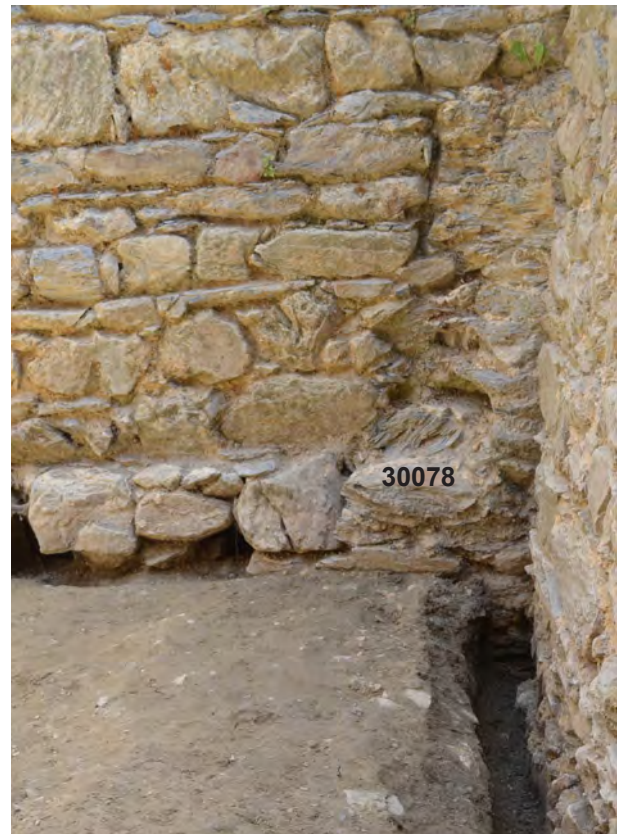
Fig.49 Le mur 30078 mis au jour en 2015 © C. Chollet, stagiaire. On remarque 2 maçonneries distinctes : une première liée au mortier de chaux blanc qui peut correspondre au mur 2+30807/30811, surmontée d'une seconde liée au mortier de chaux jaune-orangé, peut-être le départ de pont 30773.
