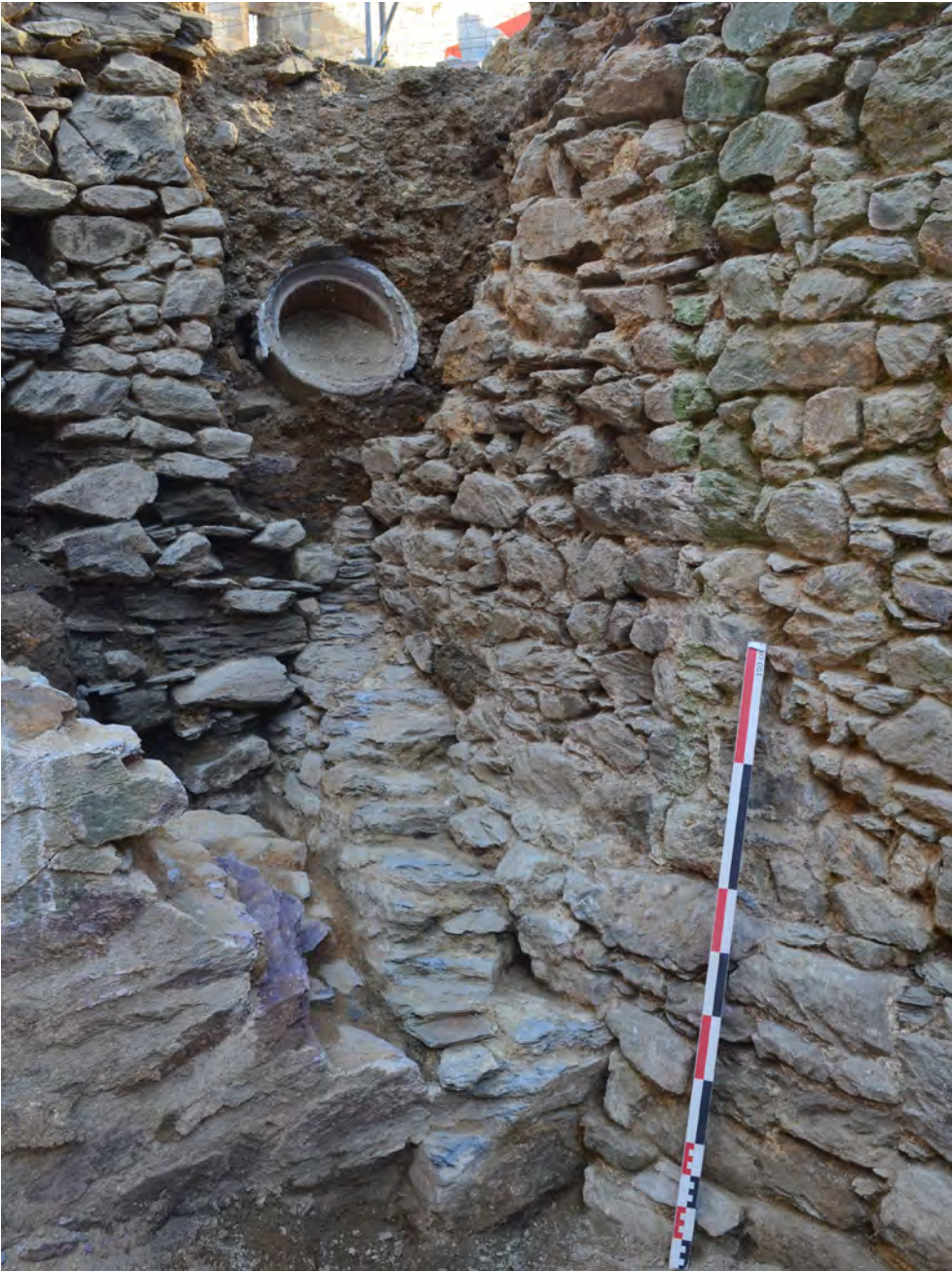
Fig.52 La base de la maçonnerie (US 30811) qui sert d'appui au mur de gorge 30054 © R. Battais, Inrap
