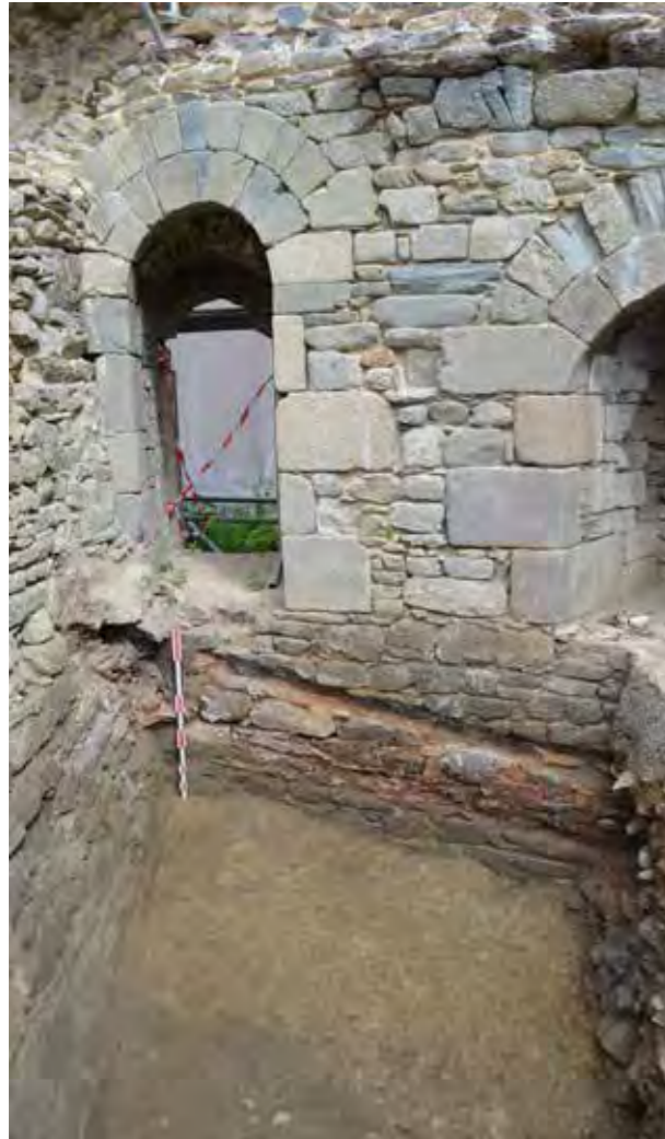
Fig.85 Le niveau de chantier 30780 © R. Battais, Inrap
