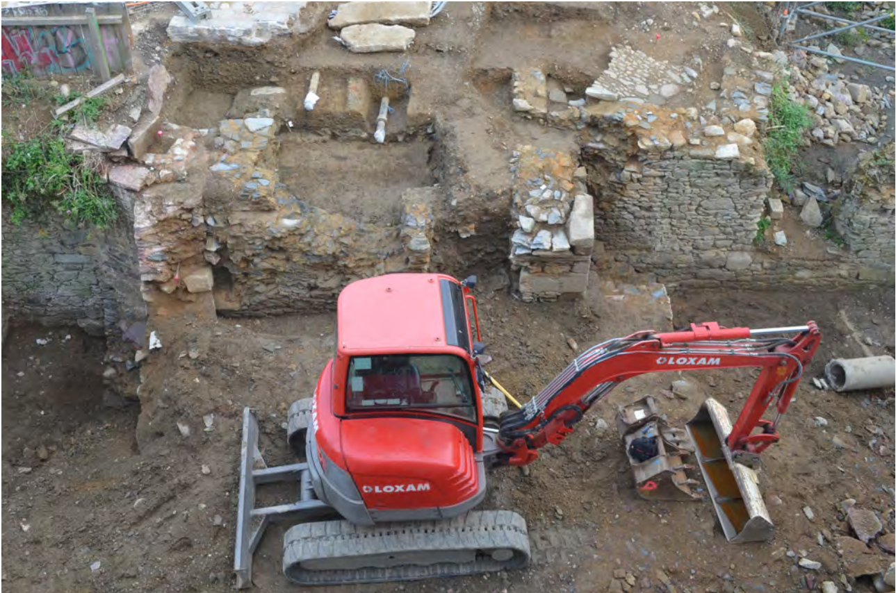
Fig.65 Vue générale de la maçonnerie 30773 © E. Esnault, Inrap
