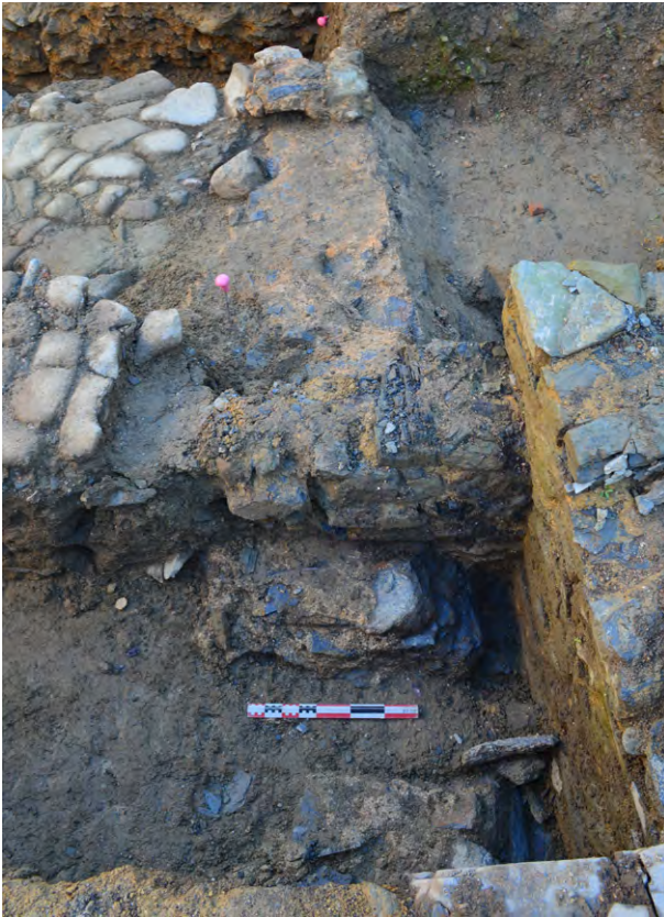
Fig.47 Le départ de pile 30807/30811 vue vers l'est © S. Le Berre, Inrap
