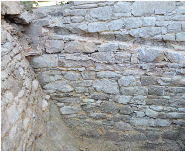
Fig.83 Le mur de bastille 30048 s'appuie contre le bord du fossé et le mur de gorge 30054 © E. Esnault, Inrap
