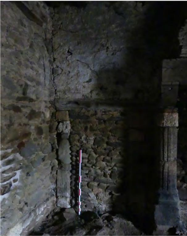
**Fig 48** (à g.) Vue de la porte (us 155), de son bouchon (us 157) et de la reprise de maçonnerie (us 159) © M. Millet, Inrap
