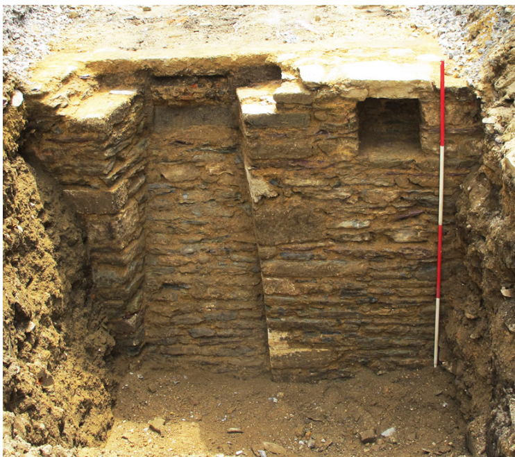
fig.18 Vue d'ensemble de la face nord du mur M11 où le négatif de poutre supportant le plancher et l'ébrasement de soupirail sont bien visibles. Le dessus de la poutre correspond au niveau du sol extérieur observable sur la face méridionale du mur © Dominique Pouille Inrap
