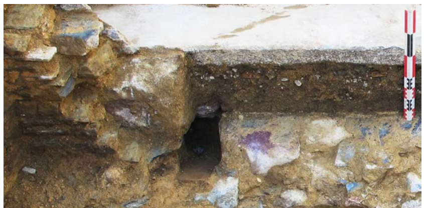
fig.11 Vue du conduit plongant sous la dalle de béton © Dominique Pouille Inrap
