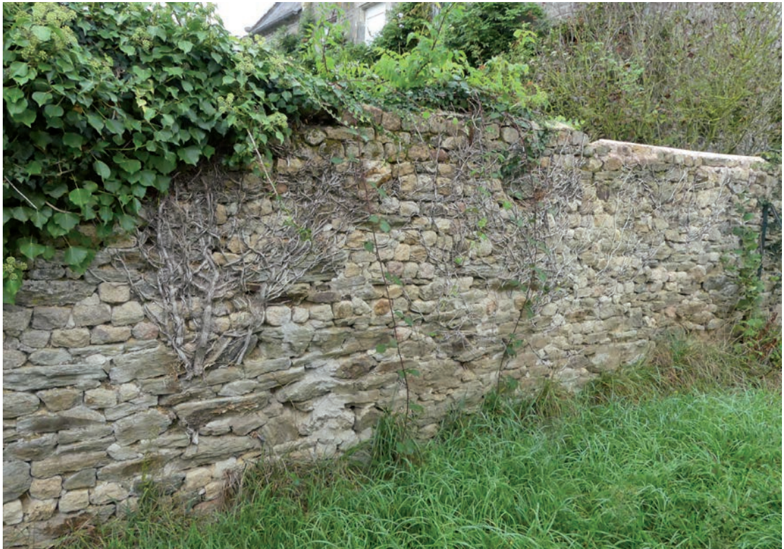
Fig. 7 : Le mur qui limite le côté ouest du terrain comporte de nombreux moellons calibrés d'origine antique.
