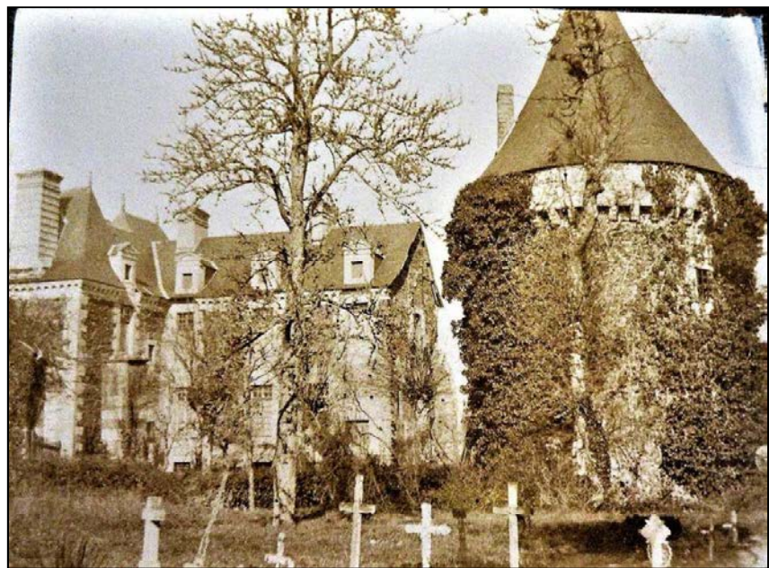
Fig. 16 : Vue côté ouest du site
