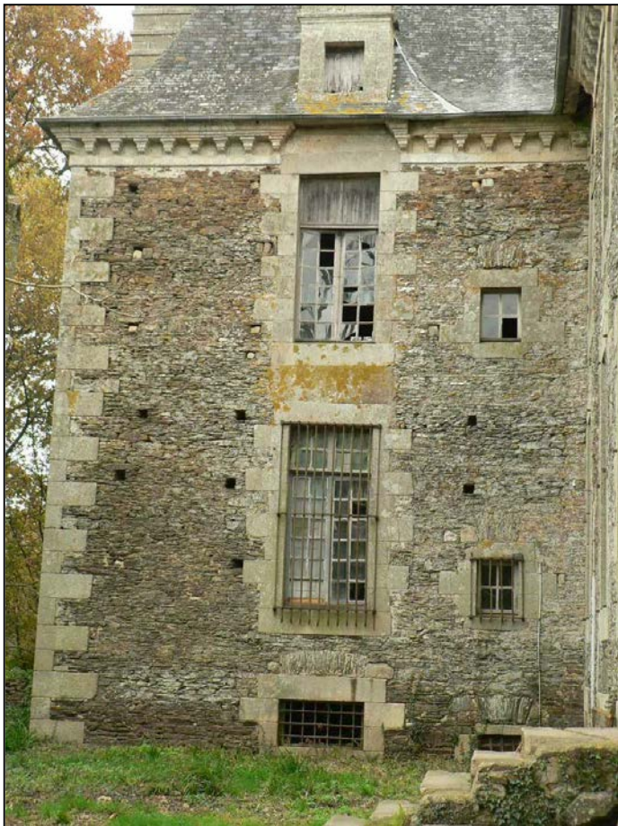
Fig. 35 : Pavillon nord élévation sud
