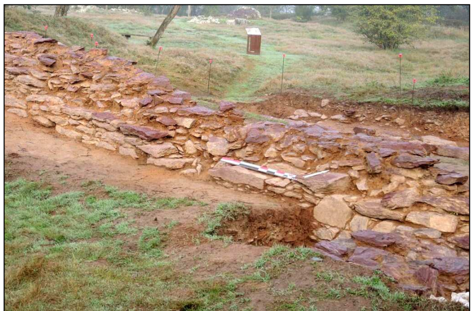
Photo 18 : parement extérieur sud
