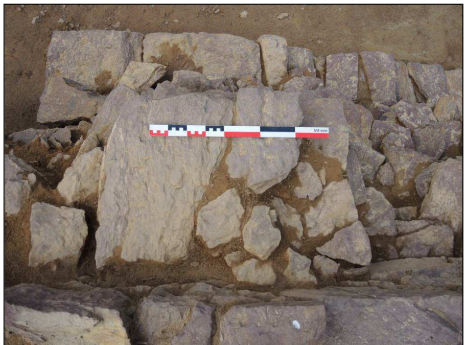
Photo 21 : contrefort F 791 appuyé sur le mur F 790
