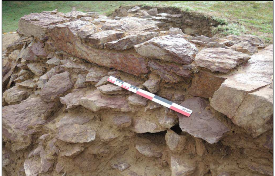
Photo 19 : parement du mur F 790 dans sa partie est
