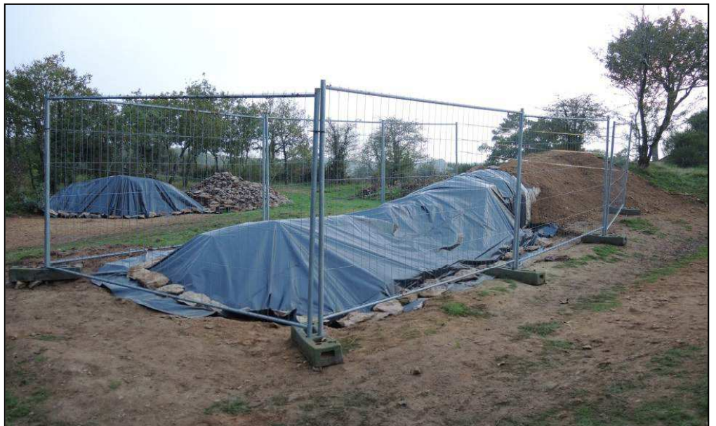
Photo 8 : ensemble mur sud après sondage en attente restauration (vue nord-est)
