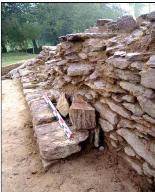
Photo 17 : Jonction tour-porte et mur de courtine F 700
