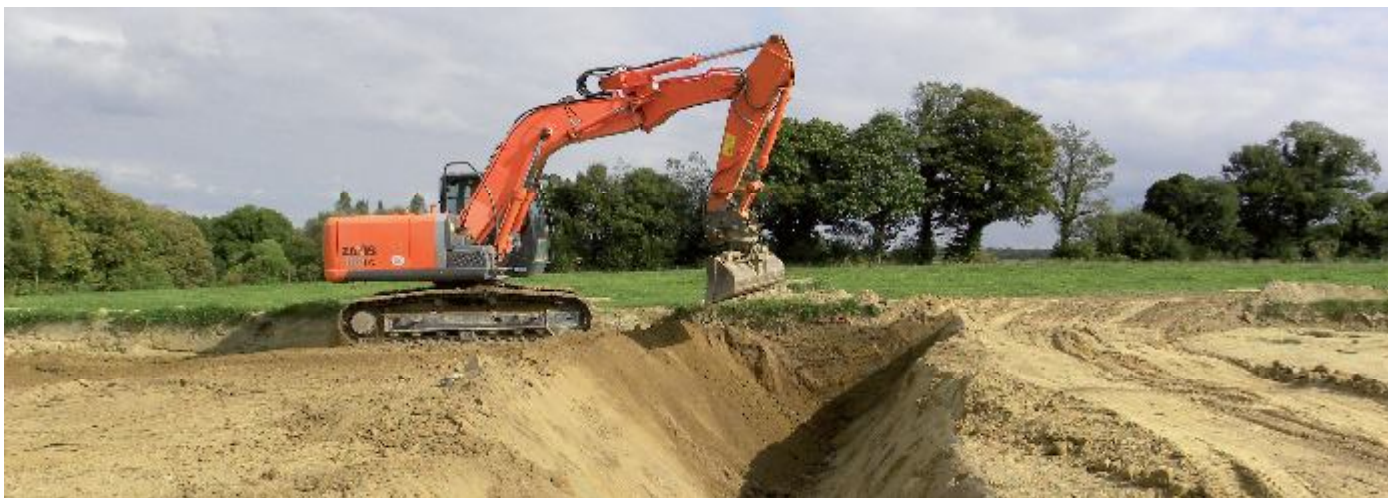
Fig. 12 - Vue d'une pelle à chenille vidant le fossé d'enceinte externe
