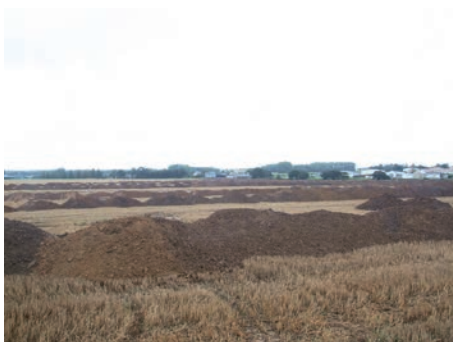
Fig. 6 Vue des tranchées de l'angle nord ouest vers le sud est
