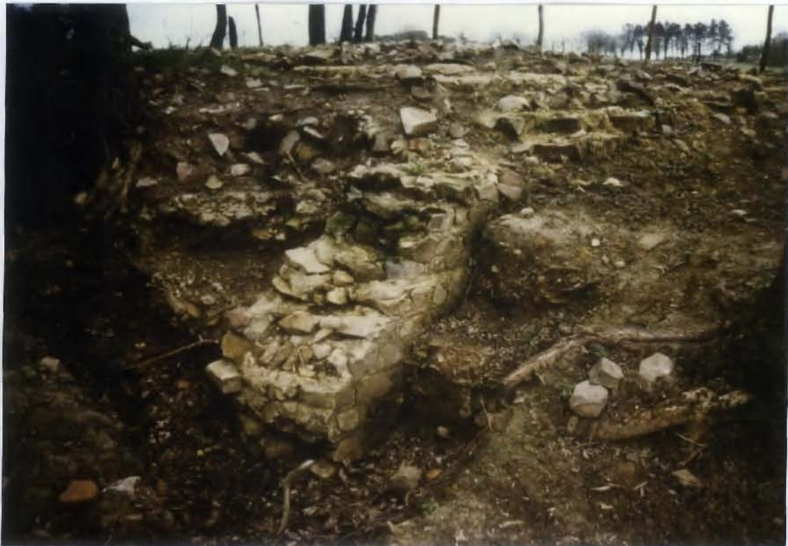
Cl. b. On remarque le soin apporté à la construction de cette maçonnerie, ainsi que les joints tirés au fer. On perçoit dans la coupe un sol de béton intérieur. (cl. G. Le Cloirec).
