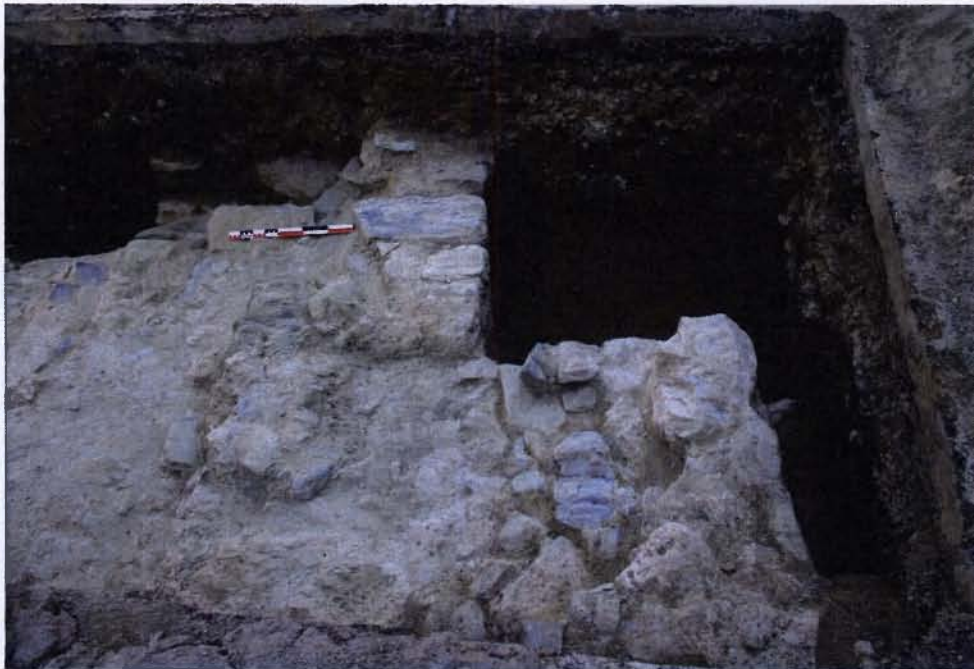
Fig. 10 : vue de l'aménagement 1003 et du mur 1005, s'appuyant sur la maçonnerie 1000, depuis le nord (Cl. L. Beuchet / Inrap)
