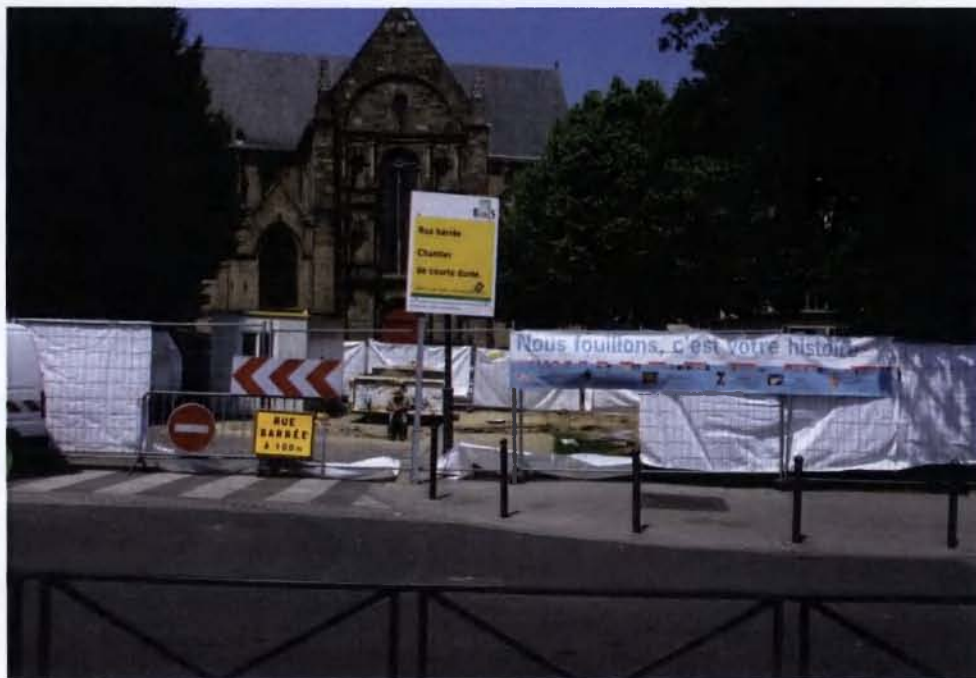
Fig. 3 : vue générale du chantier, depuis le sud (Cl. L. Beuchet / Inrap)
