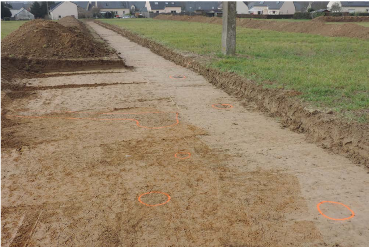
Fig. 24 Vue de l'extension réalisée dans la tranchée 11
