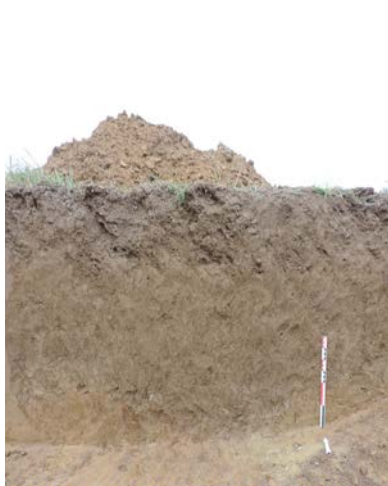
Fig. 21 Coupes du fossé 8 de la tranchée 6 © Inrap
