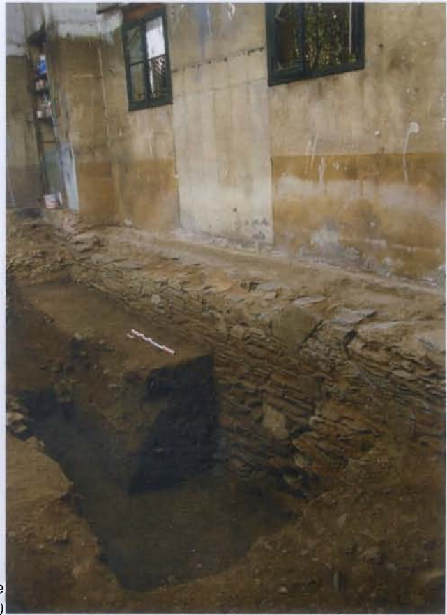
Fig. 27 : vue d'ensemble du mur 2001 (Cl. T. Béthus / Inrap)
