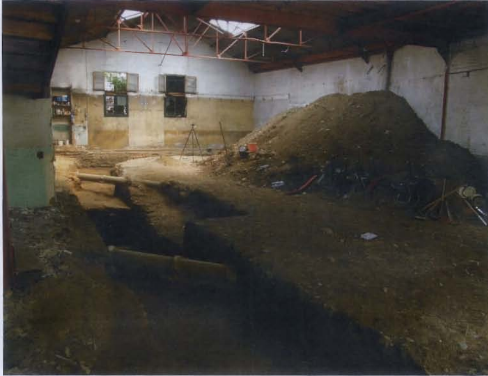
Fig. 7 : vue intérieure du bâtiment actuel (Cl. T. Béthus / Inrap)
