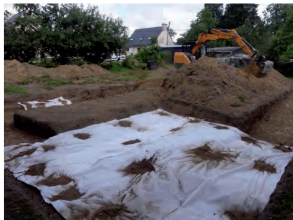
Fig. 1 Un film géotextile a été déposé sur les urnes restées en place avant le remblaiement des sondages. © Gaétan Le Cloirec
