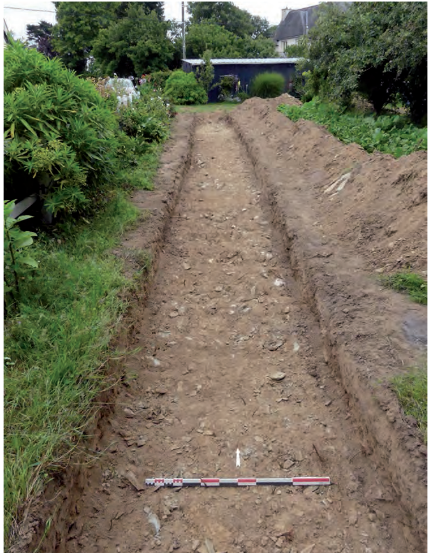
Fig. 8a Vue générale du sondage 1.
