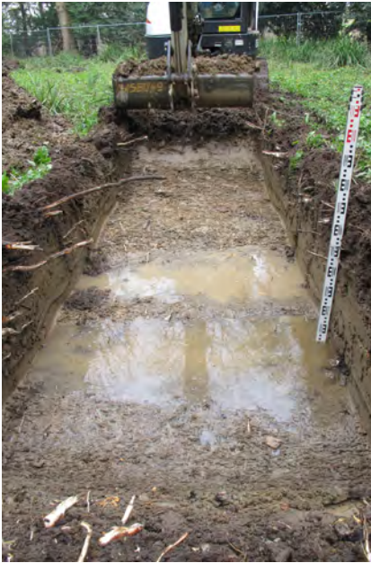
Fig. 19. Vue du sondage 10. © Dominique Pouille Inrap
