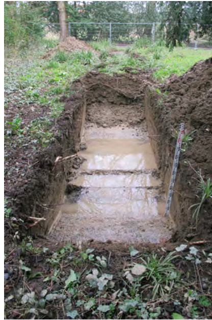
Fig. 20. Vue du sondage 11. © Dominique Pouille Inrap
