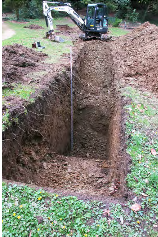
Fig. 10. Vue d'ensemble du sondage 5. © Dominique Pouille Inrap
