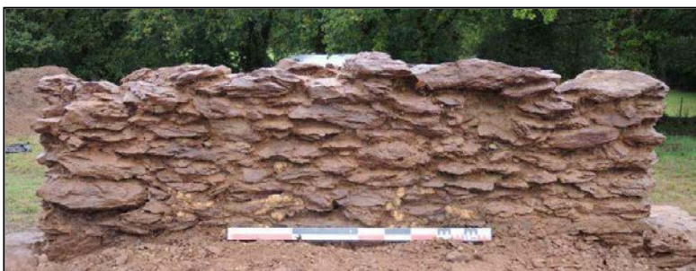
Photo 20 : vue du parement entre F 128 et F 130
