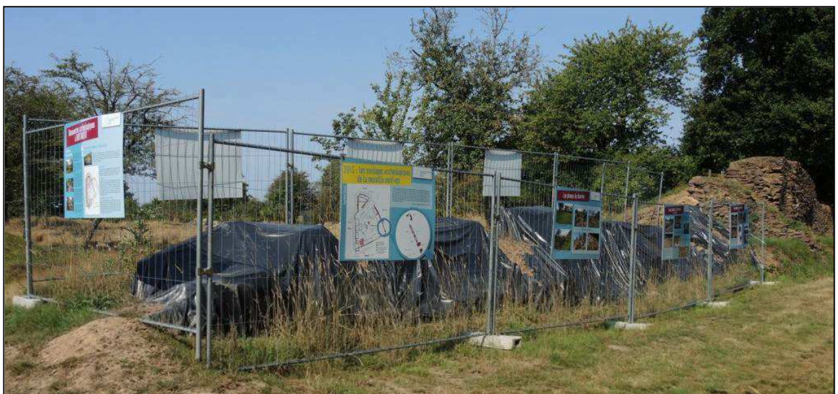
Photo 6 : panneaux d'exposition en attendant la restauration
