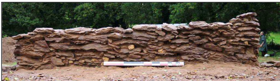
Photo 19 : vue du parement entre F 126 et F 128
