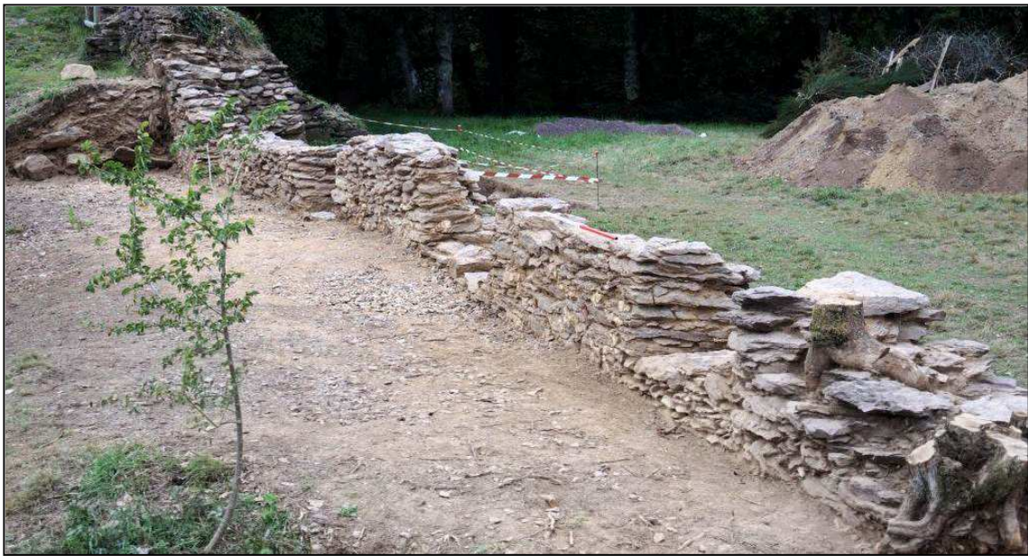
Photo 18 : vue d'ensemble du sud-ouest
