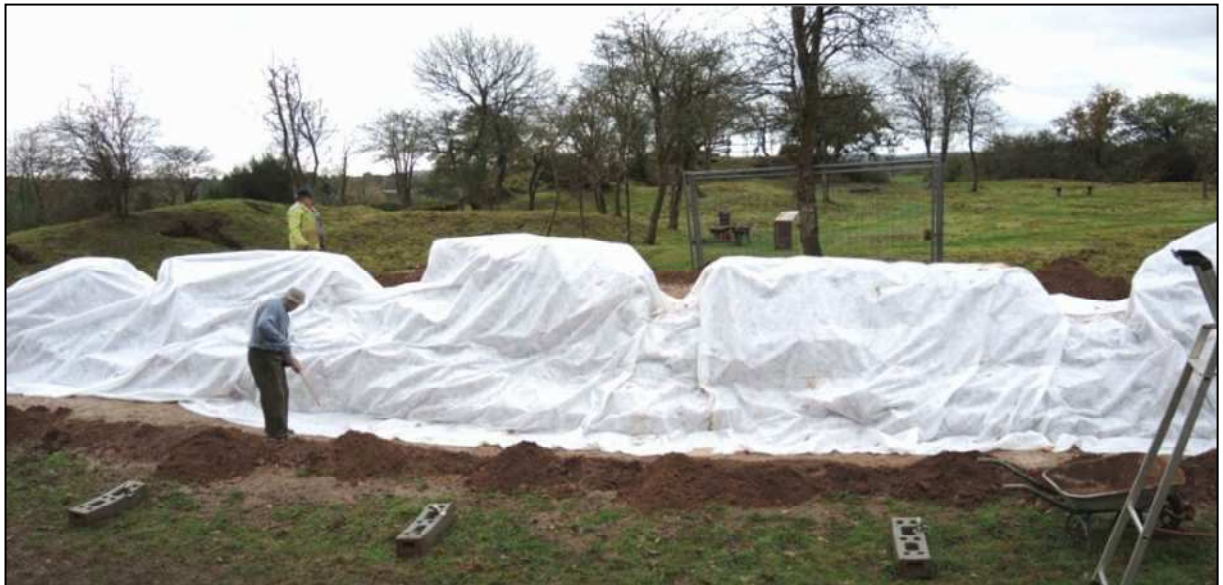
Photo 5 : pose d'un géotextile après le sondage
