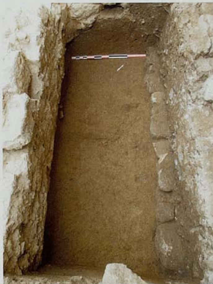
Fig 20 Ressaut de fondation supposé du mur gouttereau sud de la chapelle
