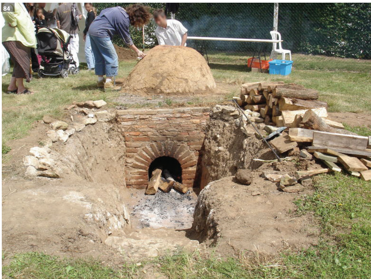
Fig. 84 Exemple pour illustrer un four gallo-romain, "reconstitué d'après un modèle retrouvé près d'Evreux". Il s'agit ici d'un four de potier. La bouche d'entrée (alandier) construite à l'aide de tuiles et terres cuites. La fosse cendrier ou de travail au premier plan. La chambre de chauffe au dernier plan (dôme d'argile) © http://pointsdecerise.canalblog.com/archives/2009/08/03/14619387.html
