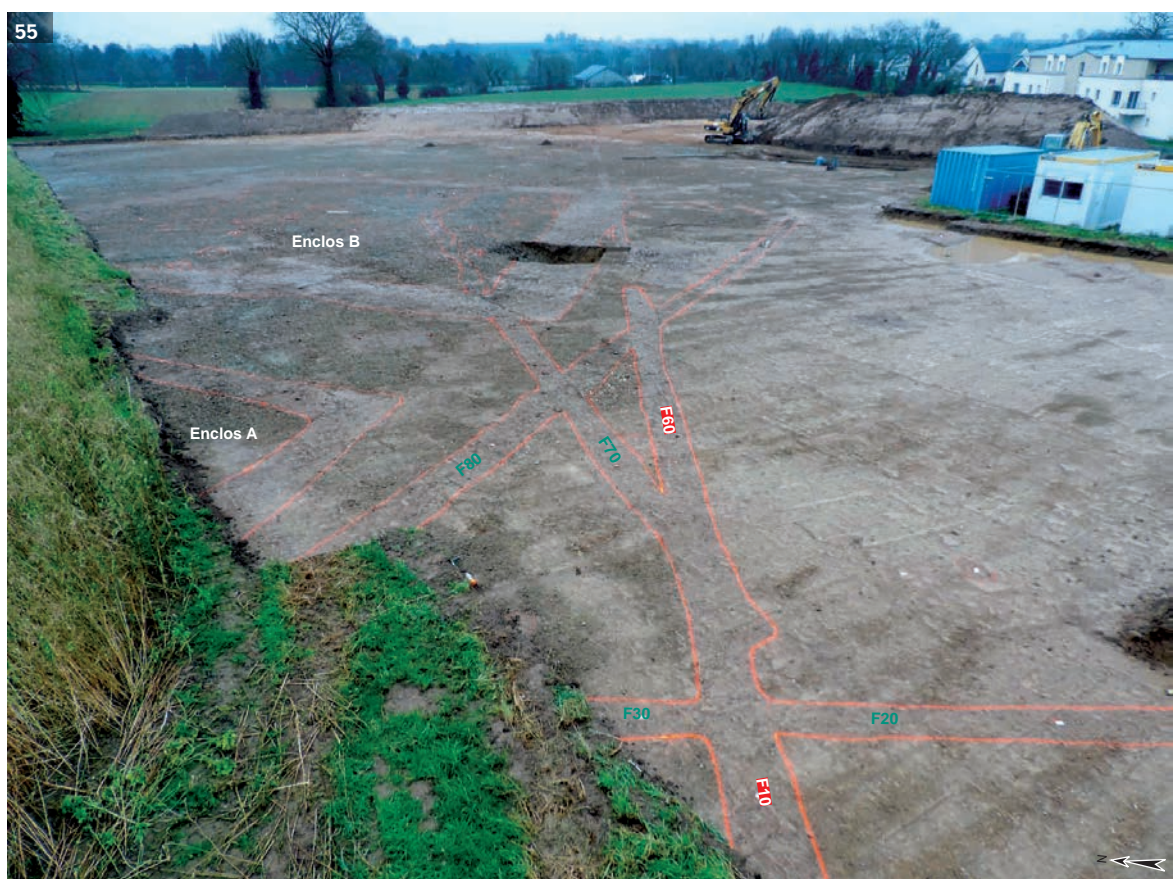
Fig. 55 Aux croisements des fossés protohistoriques (vert) et gallo-romains (rouge) © Inrap, Y. Escats, 2015.
