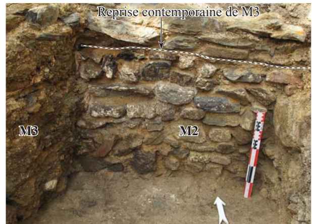
Fig.12 : Parement sud du mur M2, la partie supérieure en schiste gris est une reprise contemporaine de M3 © Dominique Pouille
