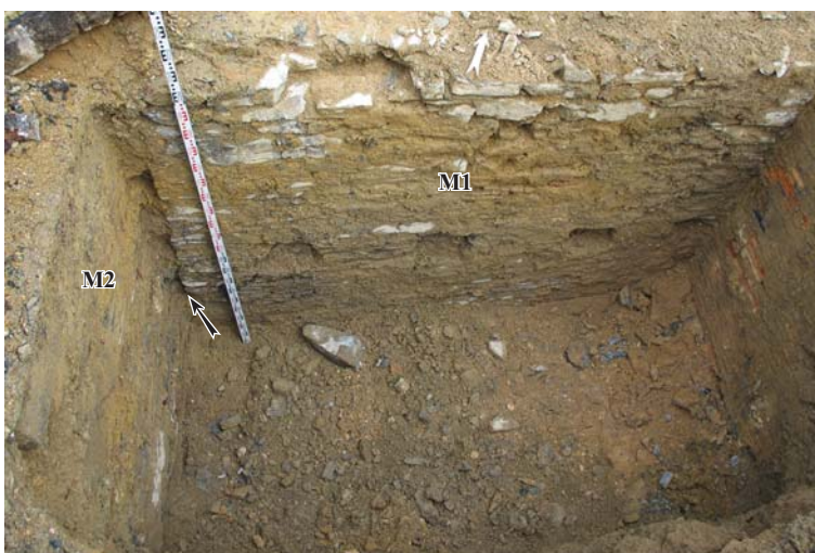
Fig.27 : L'articulation entre le contrefort M2 (à gauche) et le mur M1 présente une curieuse anomalie puisque ces deux maçonneries ne sont pas solidaires au niveau des parements © Dominique Pouille
